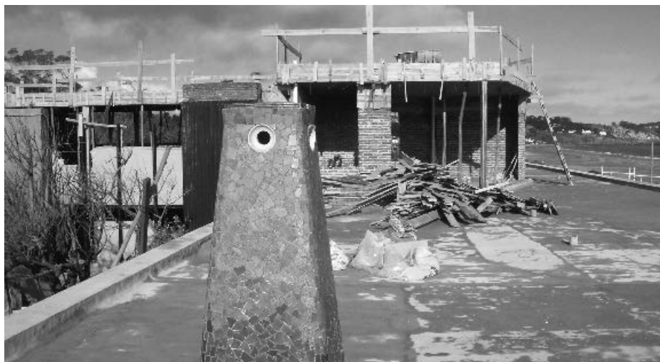
FIGURA 3. SOLANA DEL MAR (BONET, 1946). EN REFORMA. NUEVO VOLUMEN SOBRE LA AZOTEA.
