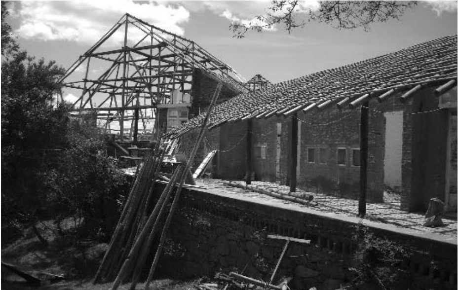
FIGURA 8. VENTORRILLO DE LA BUENA VISTA (VILAMAJÓ, 1946). EN RESTAURACIÓN. BATERÍA DE HABITACIONES Y CUBIERTA DESNUDA DEL COMEDOR.
