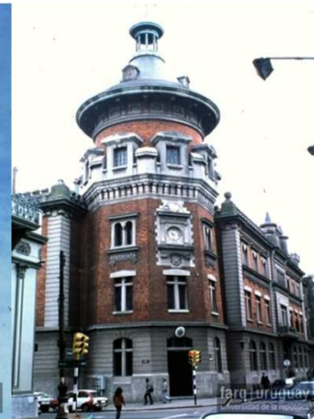
16. Cuartel de Bomberos SMA-S184-016
