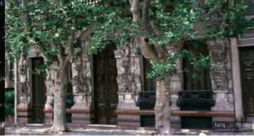
27a.Vivienda Fauno SMA-S184-027a
