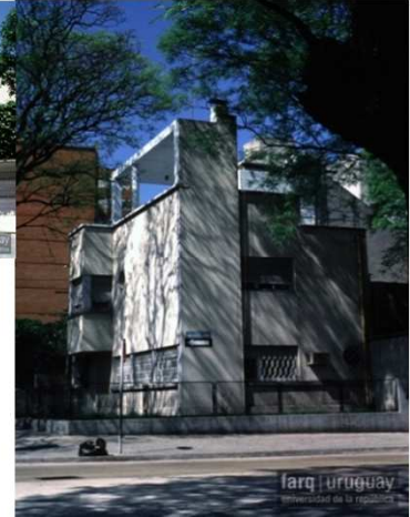
29.Vivienda Valerio Souto SMA-S184-029
