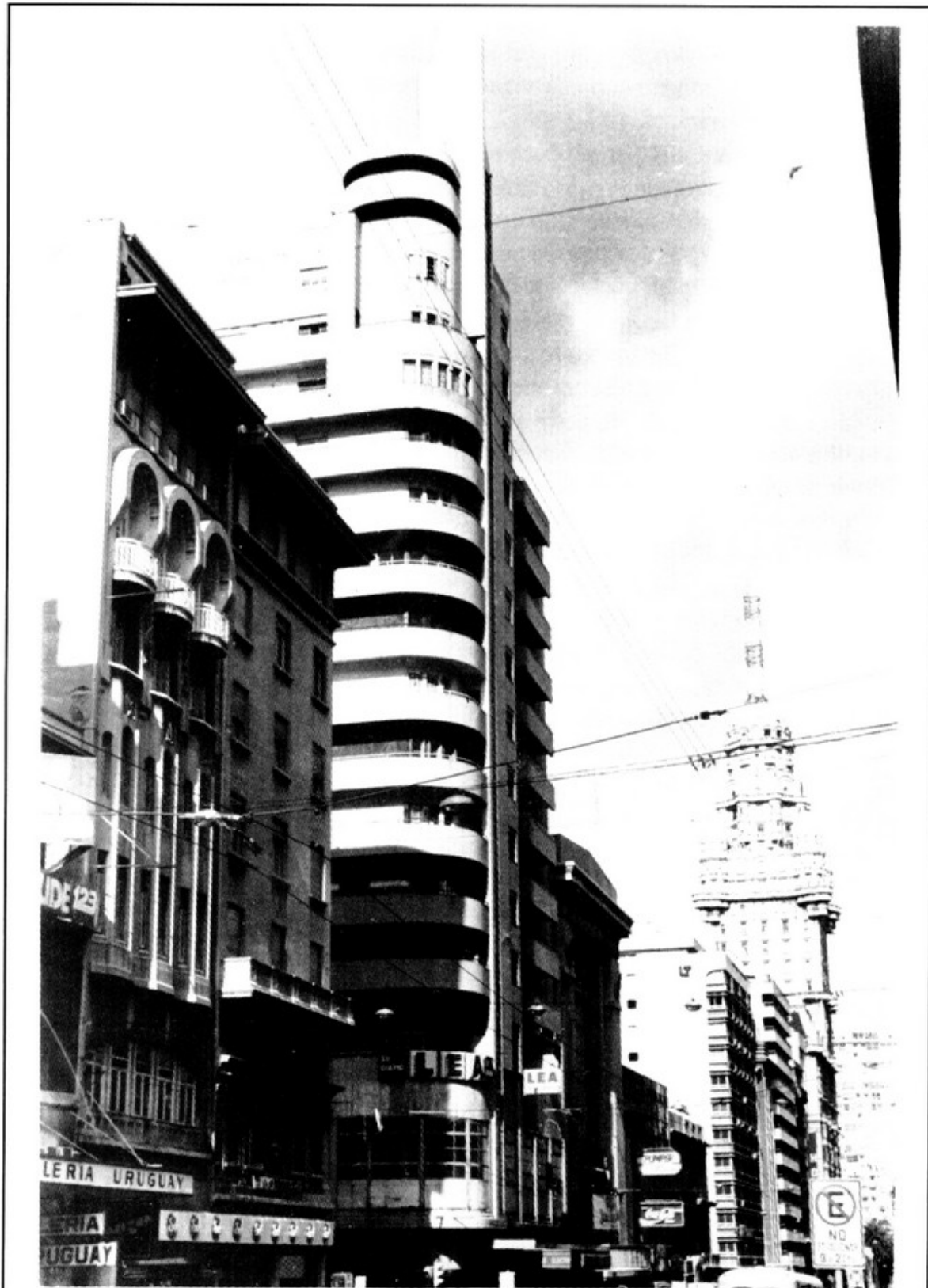
73, 74, 75 y 76. Palacio Lapido en Avda. 18 de Julio esq. Río Branco. Montevideo, 1929-33. Arqs. J. A. Aubriot y R. Valabrega.
