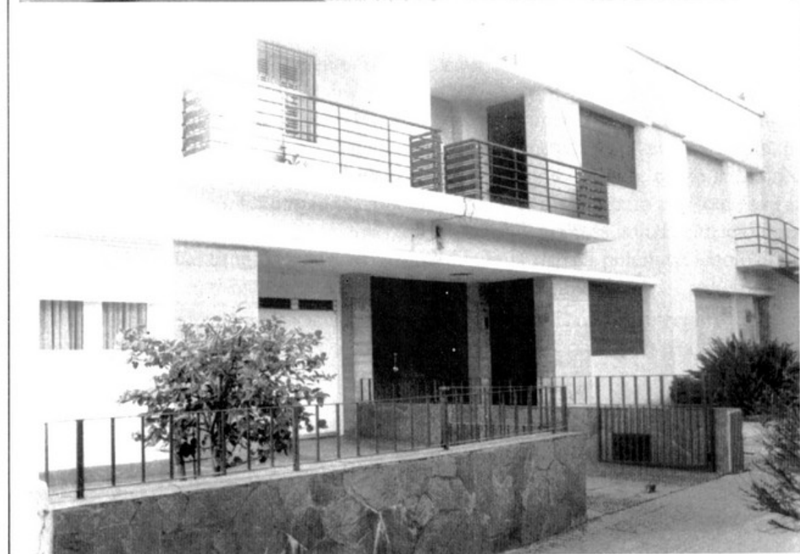
45 y 46. Grupo de viviendas en calle Treinta y Tres N° 73 al 89. Salto. Arq. Daniel J. Armstrong. Grupo de viviendas en calle Rincón N° 40 al 52. Salto. Arq. L. A. Fournié Piñeiro.
