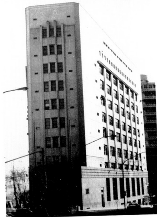
36. Banco Hipotecario del Uruguay. Calle Sarandí N° 570. Montevideo, 1937. Arq. J. A. Aubriot. Detalle interior. (Hoy desfigurado). 37, 38 y 39. Banco de Seguros del Estado. Calle Mercedes esq. Avda. Libertador Brig. Gral. Lavalleja. Montevideo, inaugurado en 1940. Arqs. B. Arbeleche e I. Dighiero.
