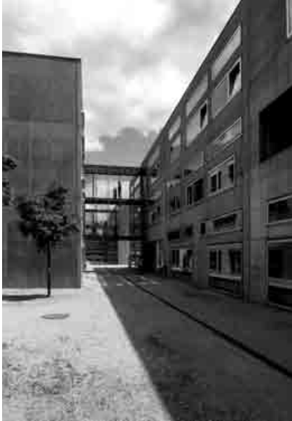
Fig. 8. Calle exterior. Institutos de Informática y Electrotecnia de la Universidad de Graz (1994-2001), Riegler Riewe. Foto: Marta Pelegrín, 2016.
