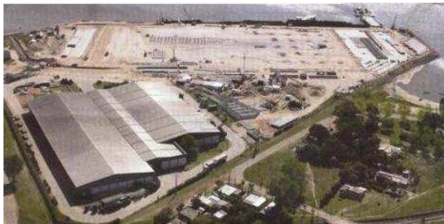
Ilustración 8: Construcción Depósito Techado.
