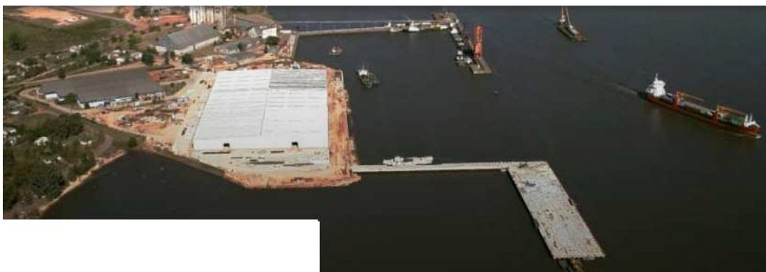
Ilustración 13: Construcción de la terminal.
