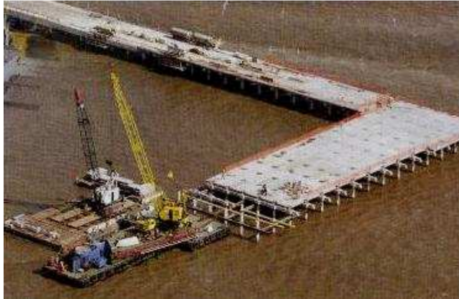
Ilustración 7: Construcción Muelle Oceánico.
