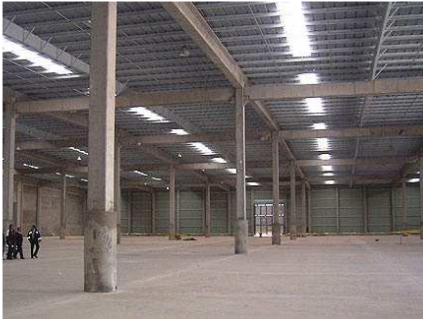
Ilustración 10: Vista interior del depósito.
