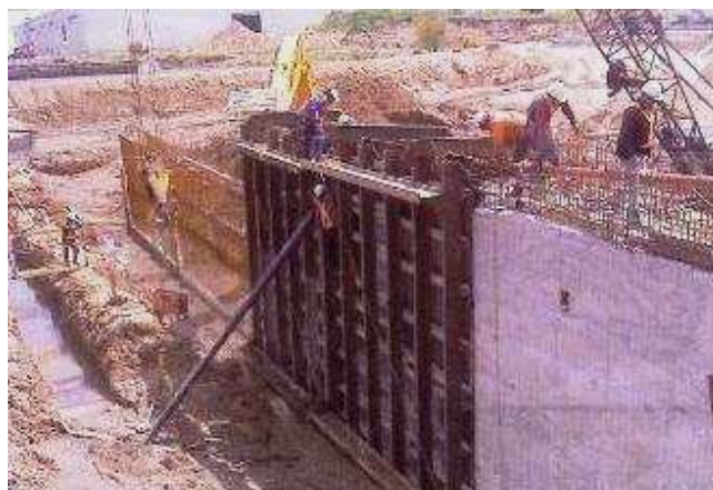
Ilustración 4: Construcción Muelle Oceánico.
