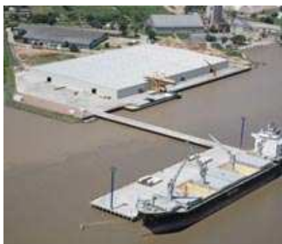
Ilustración 14: Finalización de las obras en la terminal Ontur International.
