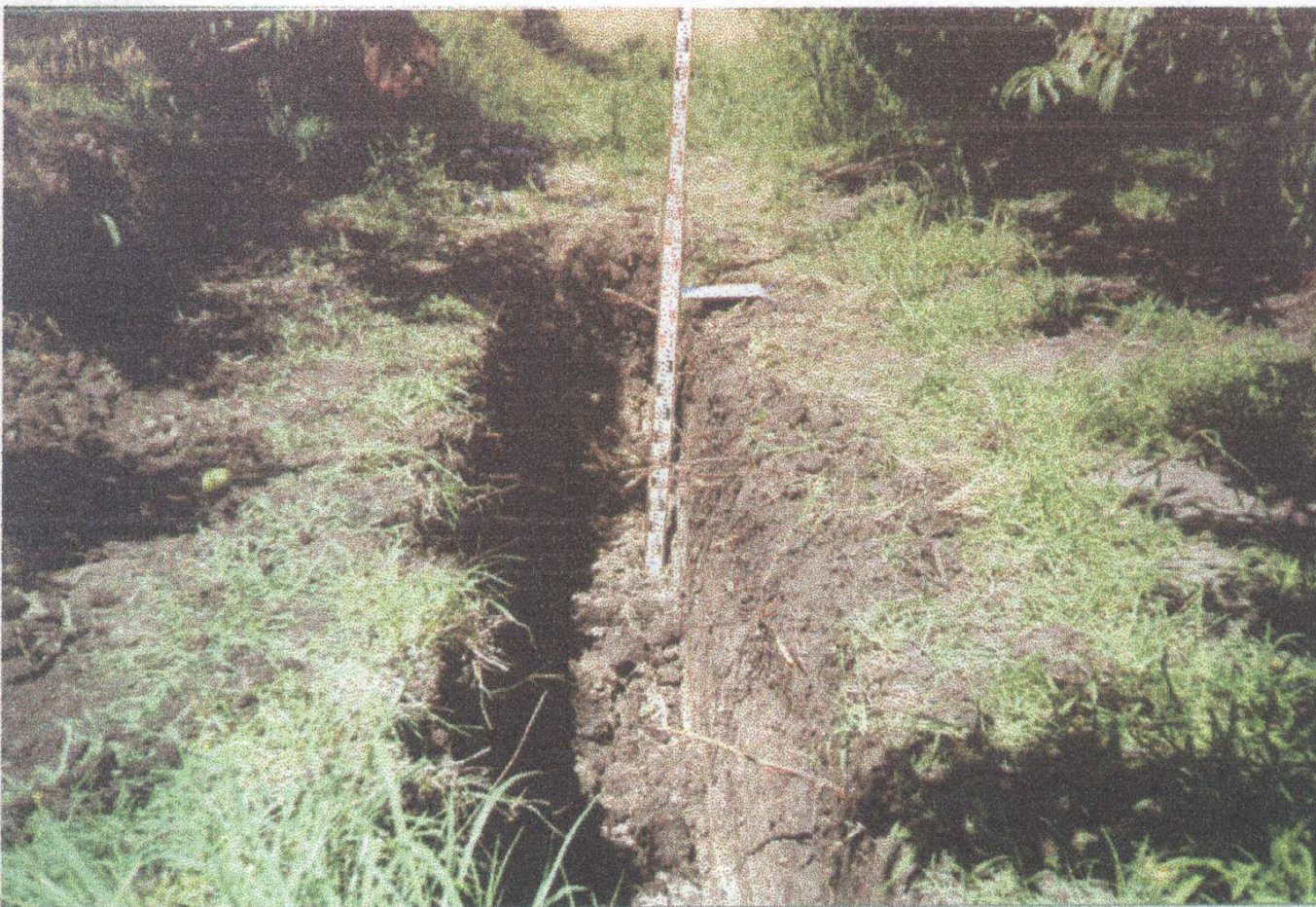
Figura N° 33 : Zanja realizada con la finalidad de facilitar la extracción de los bloques de suelo.
