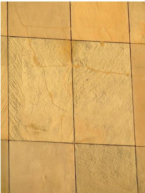
Fig. A11. Erosión (erosión diferencial)
