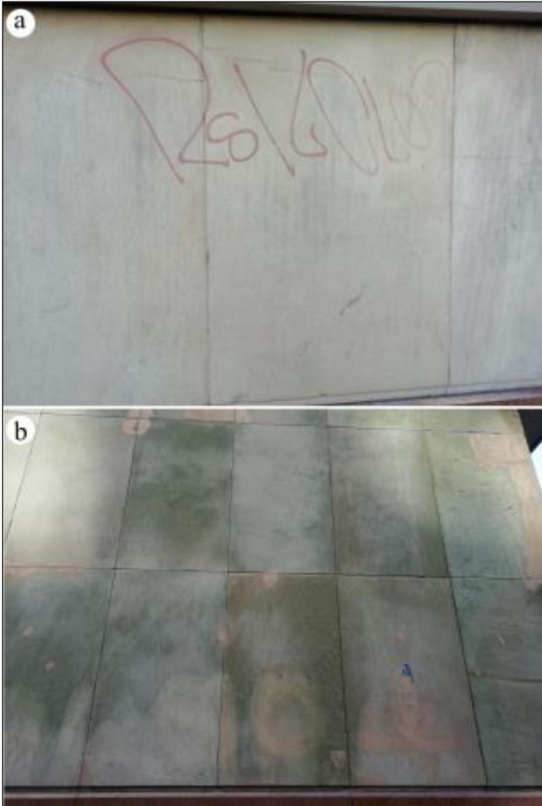
Figura. 32. Imágenes de fachada exterior Hotel Radisson. a) Graffiti, erosión diferencial; b) Manchas de humedad, decoloración asociada a la remoción de graffiti, perforación. Dimensiones placas 108x75 cm.
