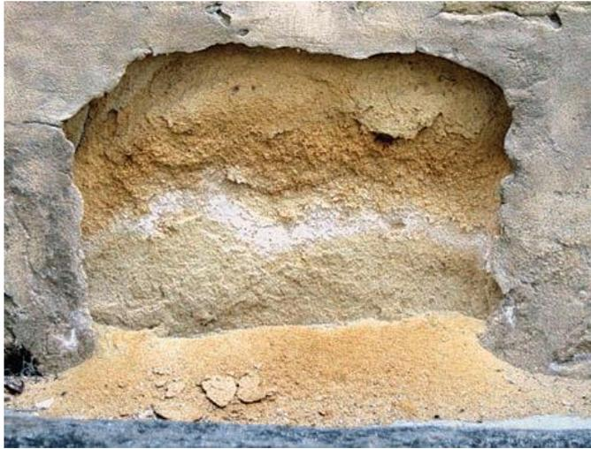
*Fig. A15. Depósito (Desechos orgánicos) Fig. A16. Depósito (Material desprendido de la propia roca)
