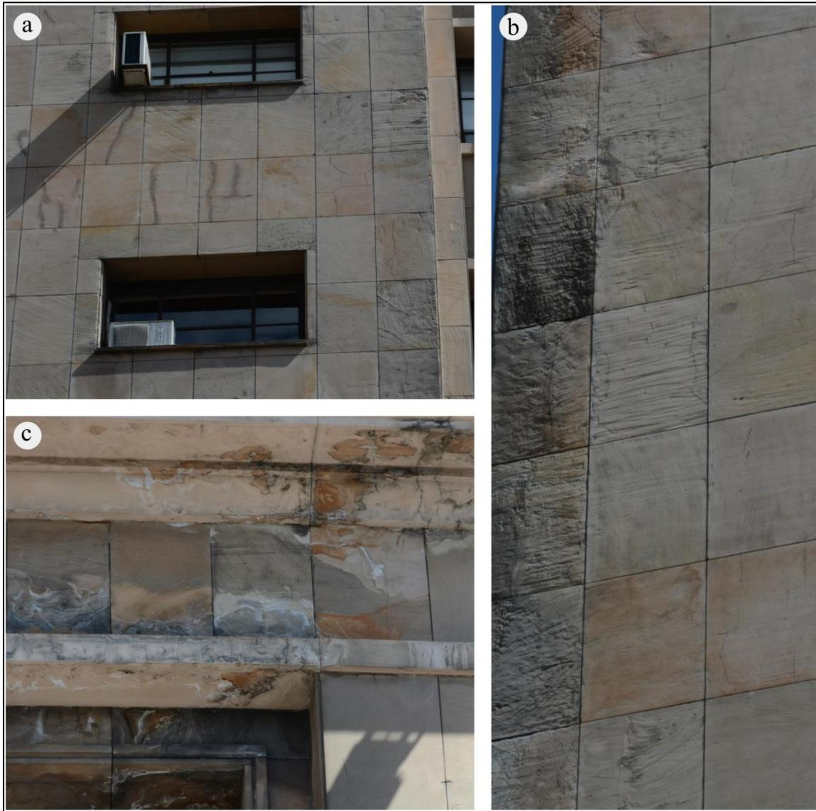
Figura. 34. Fachada norte Edificio ANCAP. a) Porción de fachada donde se distinguen variados tipos de deterioros, grietas, perforaciones, faltantes, erosión diferencial, entre otros; b) Hilera de placas con mayor concentración de deterioro, en extremo noreste de la edificación a una altura aproximada de 20 – 30 metros, quedando expuesta presumiblemente la estratificación original de la roca; c) Sector con gran densidad de ampollas y cristalización de sales. Dimensiones placas 133x68 cm
