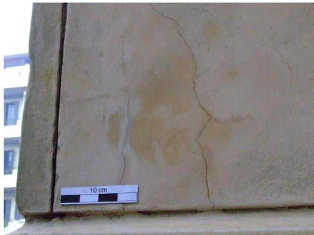
Fig. A1. Fractura en placa de arenisca.
