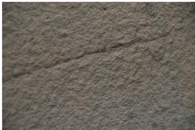
*Fig. A9. Disgregación granular*
