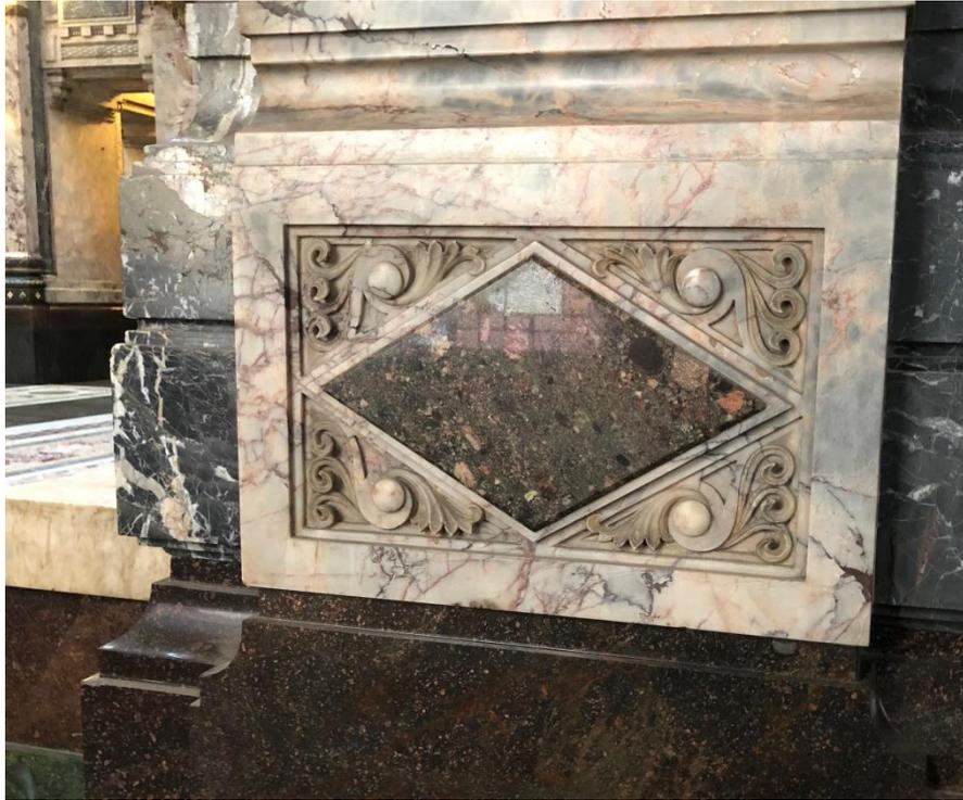
Figura. 18. Placa pulida de Conglomerado Las Ventanas (centro). Destaca el buen brillo que la roca alcanza al ser pulimentado.
