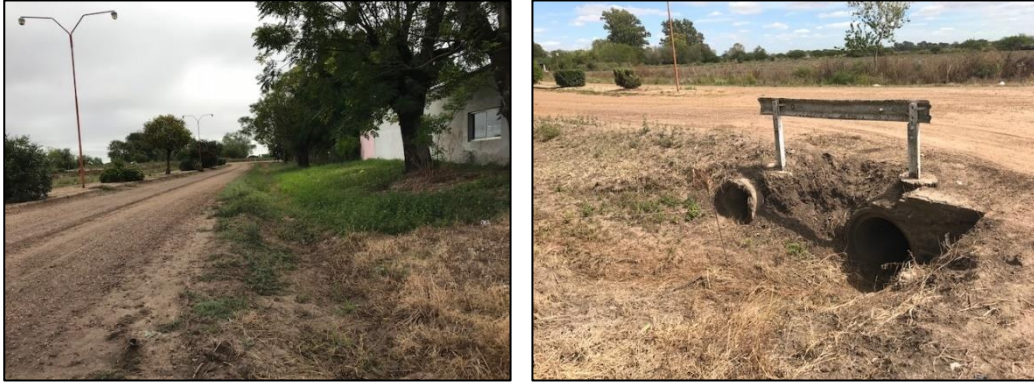
Figura 16 – Zanja sobre calle Francisco Beiró
