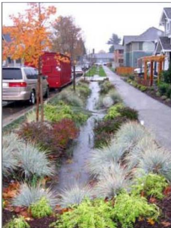
Figura 27 : Cordón impermeable y cuneta permeable
