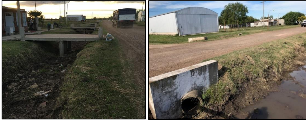
Figura 14 – Canal en calle Pedro Lucero
