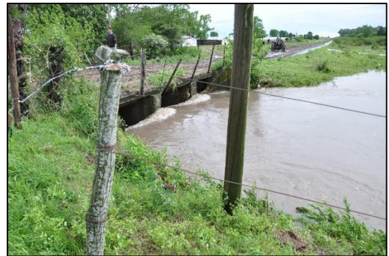
Figura 60 : Puente de Latorre - Aguas arriba (1/11/2012)
