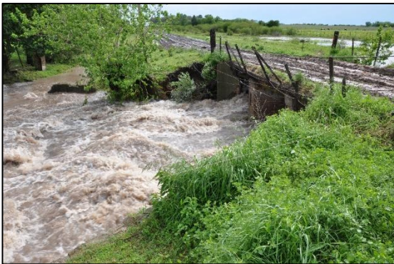
Figura 59 : Puente de Latorre - Aguas abajo (1/11/2012)
