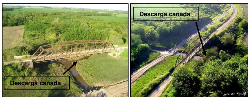
Figura 7 – Vista aérea de la descarga de la cañada en el arroyo Clé (Imágenes cortesía de la Municipalidad Gobernador Mansilla)
