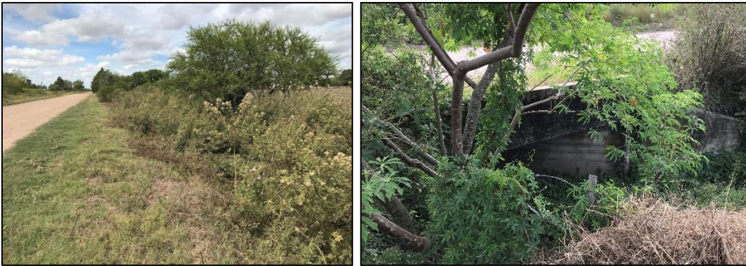
Figura 17 – Zanja sobre calle Rocamora continuación zanja Francisco Beiró, descarga a cañada "Rocamora"
