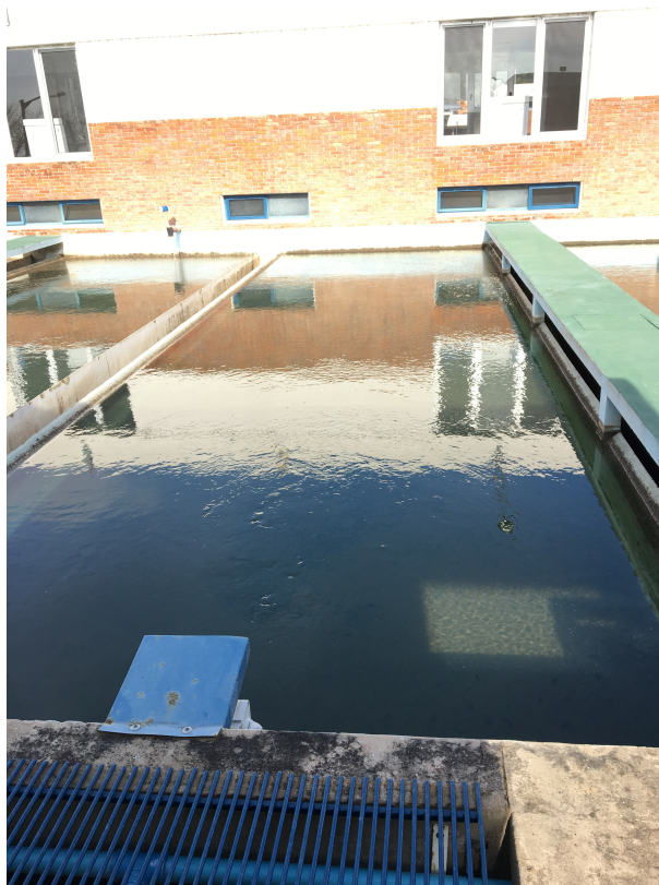
Figura 41: Filtro de doble manto.
