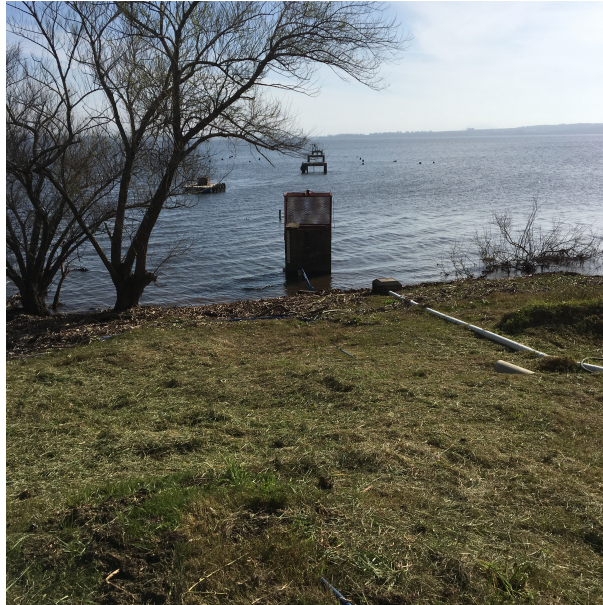
Figura 6: Obra de toma.
