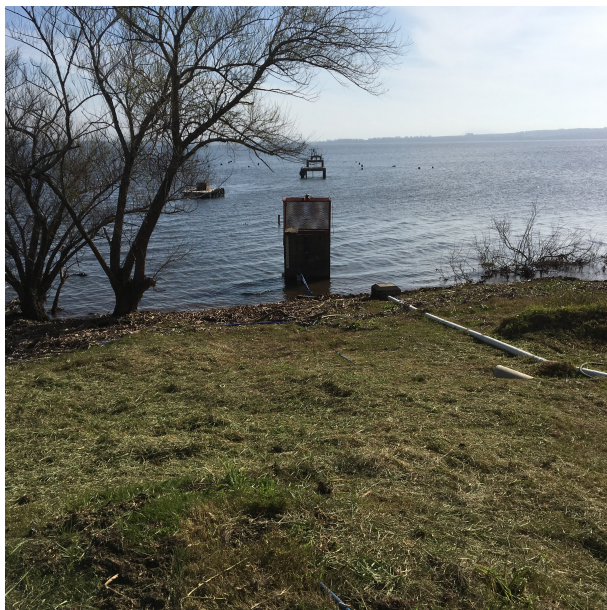
Figura 36: Obra de toma.
