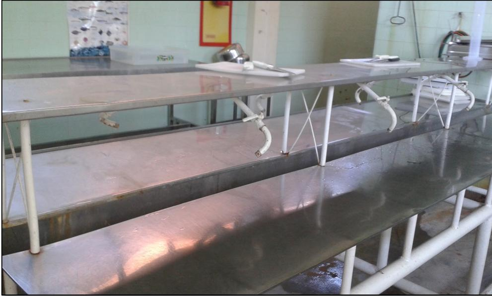
**Figura 8:** Mesada de acero inoxidable, con canaleta central para desperdicios y agua potable corriente.
