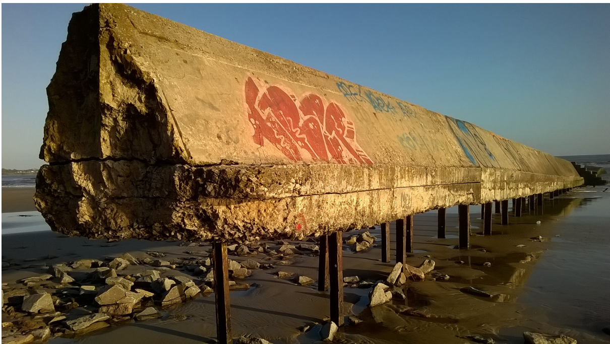
FIGURA 4. Vista en detalle de espigón Oeste (8) en Las Vegas mostrando evidencias de erosión (fotografía Octubre 2016).
