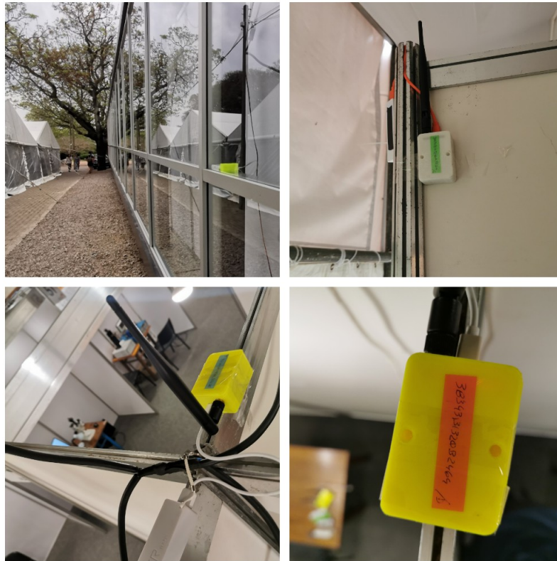
Figura 33: Instalación de nodos en Ingeniería de Muestra 2019.
