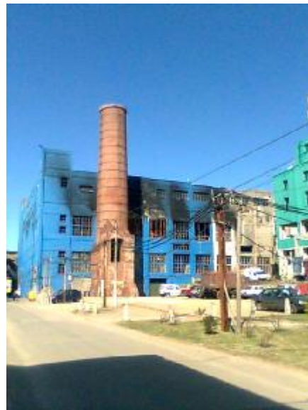
Edificio afectado por el último incendio. Foto tomada durante la visita el 19/08/08.
