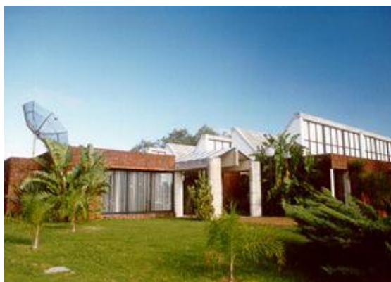
Fachada de la incubadora, en el predio del LATU. Fuente: www.ingenio.org.uy . Consulta junio 2008.
