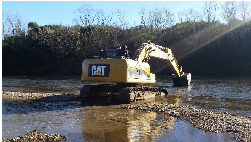
Figura 5.8: Tareas de excavación de las trincheras con retroexcavadora, en julio de 2017.
