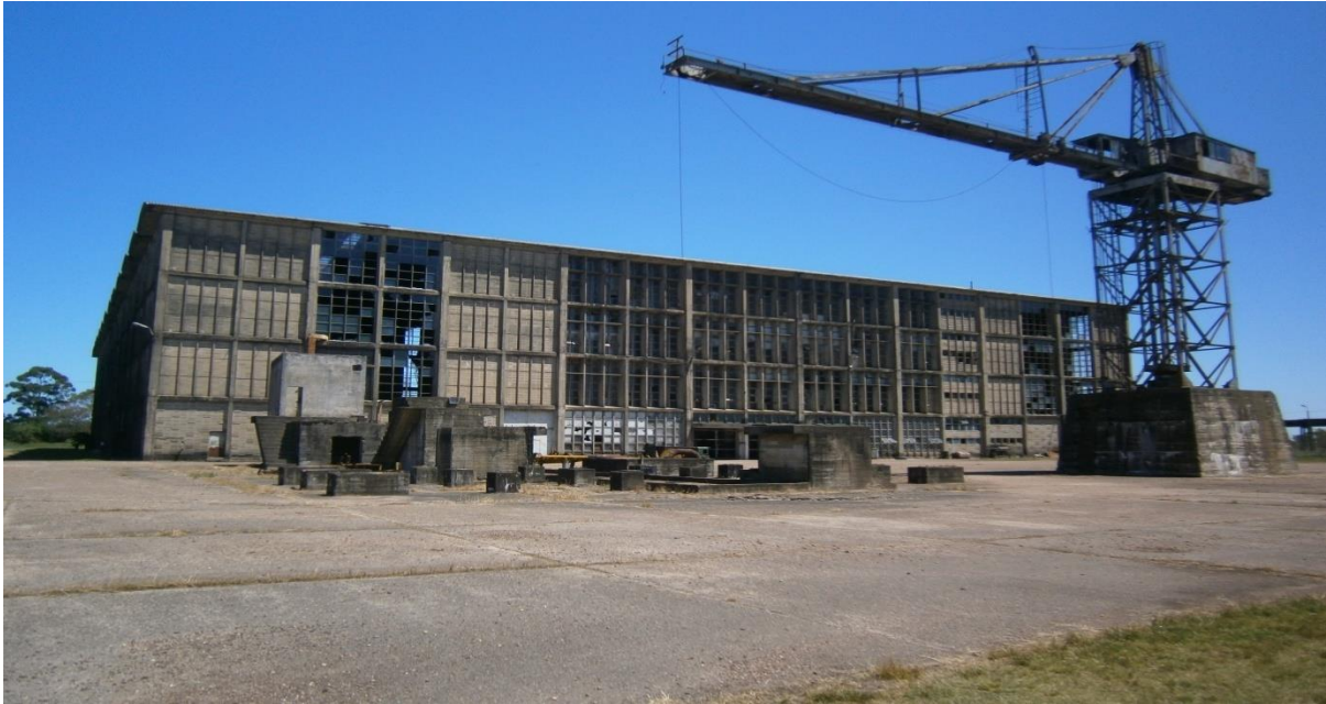
Fotografía de la entrada a la planta industrial, tomada en octubre de 2018.
