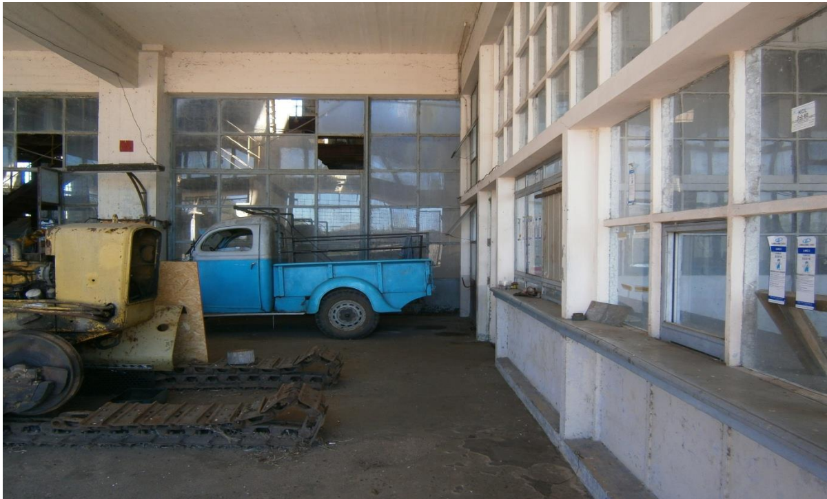
Fotografía del interior de la planta industrial, tomada en octubre de 2018.
