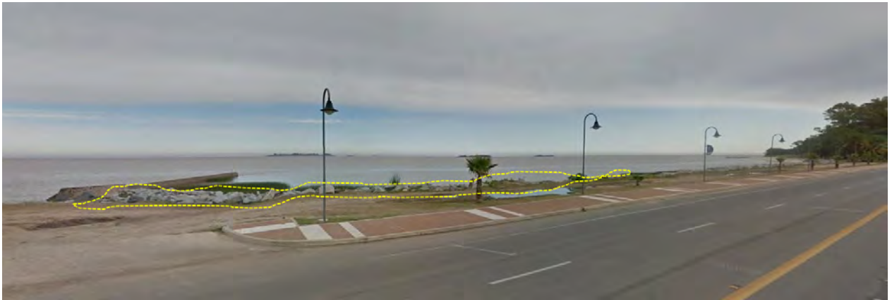
Figura 3.9: Estado actual del antiguo afloramiento en la Bahía de Colonia, Departamento de Colonia. En amarillo se resaltan los gaviones, próximos al espigón y en el contorno costero occidental. Vista al noroeste, de Junio 2015. Modificada de Google Maps.
