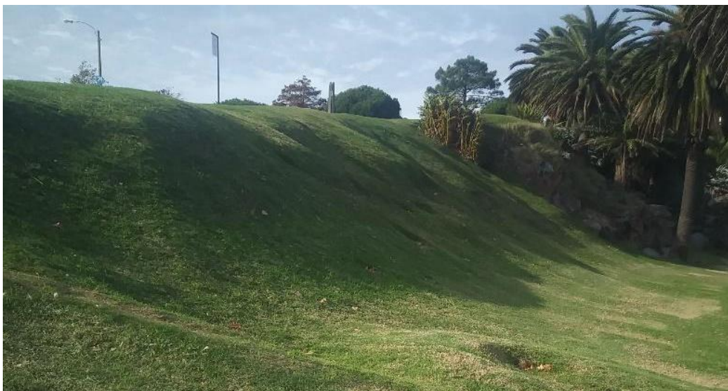
Ilustración 26: Zona de relevamiento específica, talud sobre el cual se ubica la curva de nivel a estudiar.
