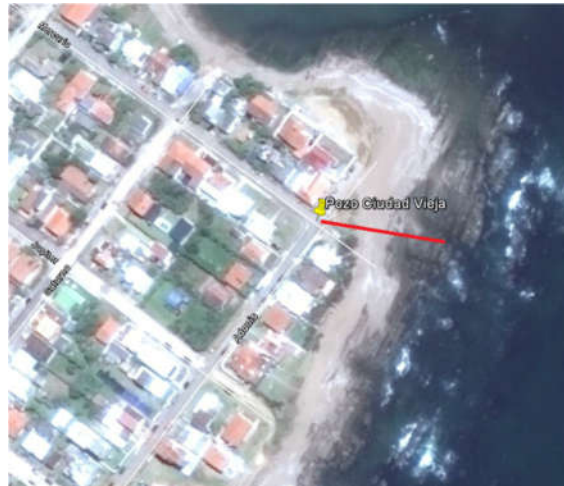
Figura 7. Aliviadero estación de bombeo Ciudad Vieja.
