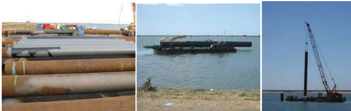
Figura 5-1 - Acopio de camisas metálicas para pilotes (izquierda) Transporte de camisas metálicas en pontón (medio)Hinca de camisa metálica (derecha). Fuente (Pacoret, 2012).
