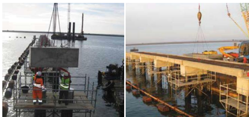
Figura 5-3 - Cabezales prefabricados (izquierda) Encofrado pre moldeado de la losa (derecha). Fuente (Pacoret, 2012).
