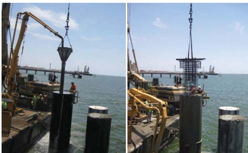
Figura 5-2 - Hormigonado y colocación del armadura superior del pilote. Fuente (Pacoret, 2012).
