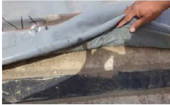
Figura 2.4 Goma adherida al hormigón
