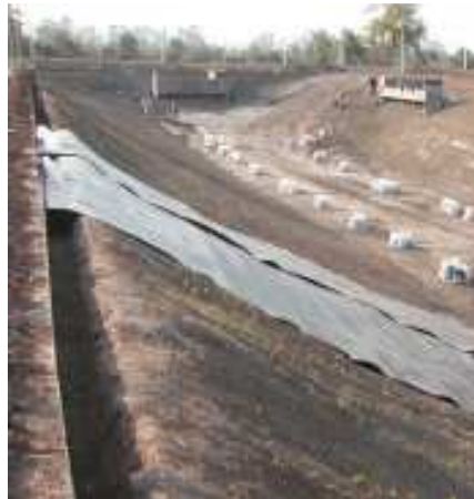
Figura 2.3 Fotografía ejemplo de zanja de anclaje
