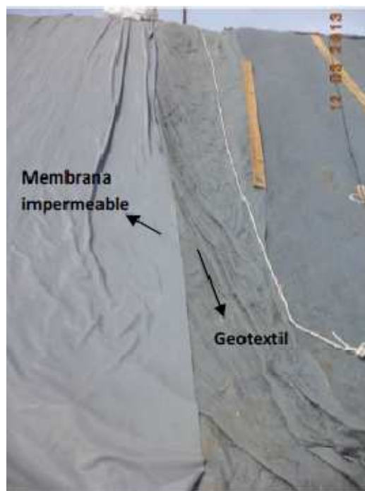
Figura 2.1 Colocación de membrana sobre el geotextil en los taludes de una laguna
