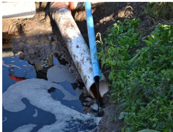
Fotografía 2-2 Descarga del lixiviado
