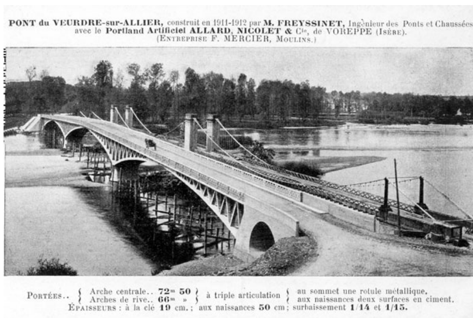
Figura 1.1: Puente Le Veudre.
