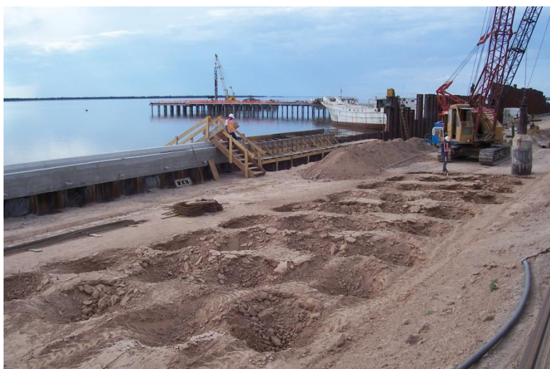
Figura 2.9. Huellas resultantes luego de la compactación dinámica en un terraplén de la Terminal Portuaria Ontur, Nueva Palmira. Tomado de LCCF (2007).
