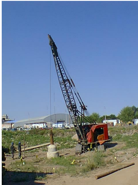
Figura 2.8. Dispositivo para la compactación dinámica en un terraplén del Puerto de Montevideo, pesa de 85kN, altura de caída de hasta 6m. Tomada de Facultad de Ingeniería (2005).
