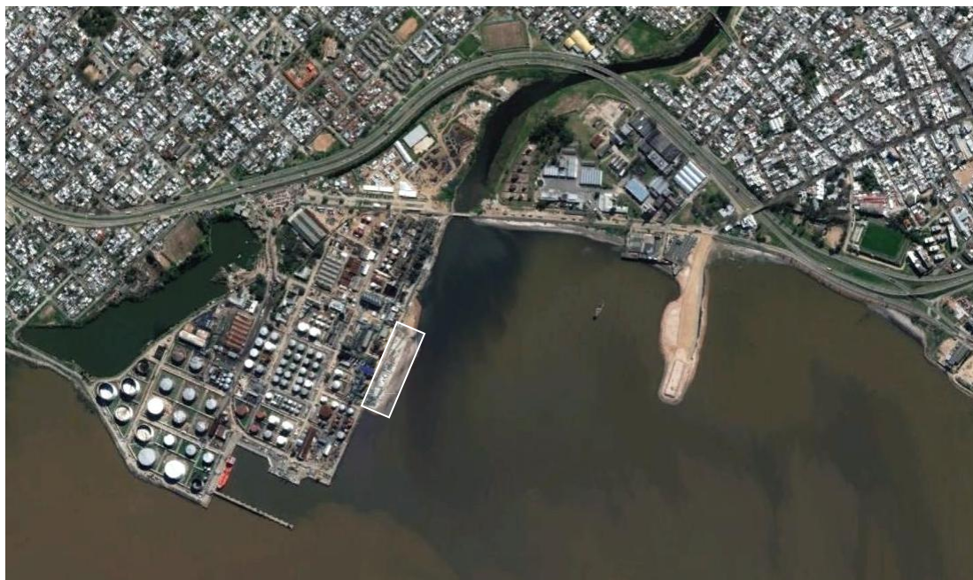
Figura 5.1. Ubicación del terraplén.
