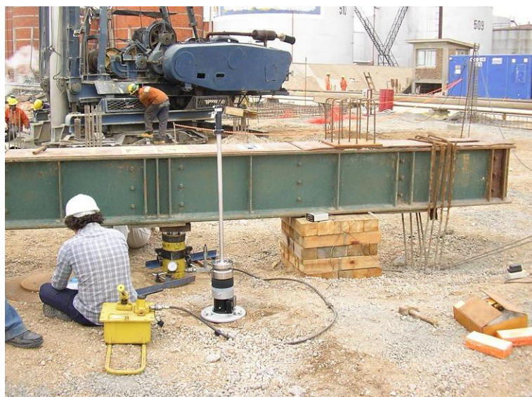
Figura 5.5. Ensayo de placa N°8 a cota +3.8m con placa de 30cm de diámetro y zona de ensayos de placa de 50cm y 80cm de diámetro. Al frente equipo LWD.
