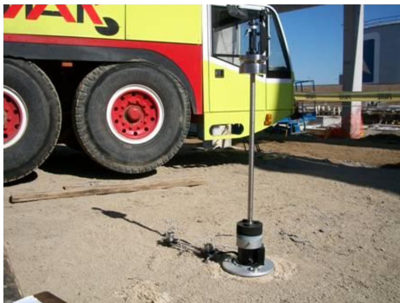
Figura 5.6. Equipo LWD en zona de grúa de 300t.
