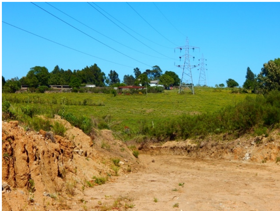
Figura 9 - Talud Sureste y línea de alta tensión
