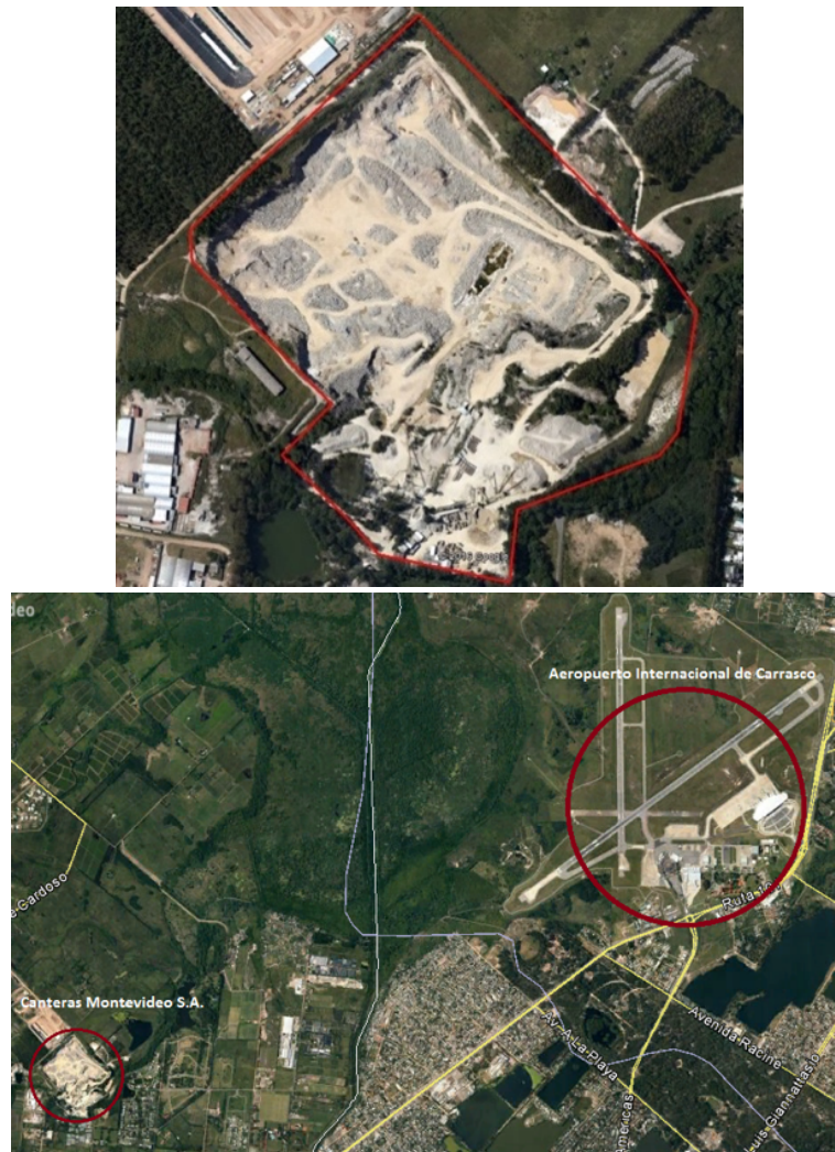
Figura 2 - Vista aérea de las Canteras Montevideo S.A. y su proximidad al Aeropuerto Internacional de Carrasco
