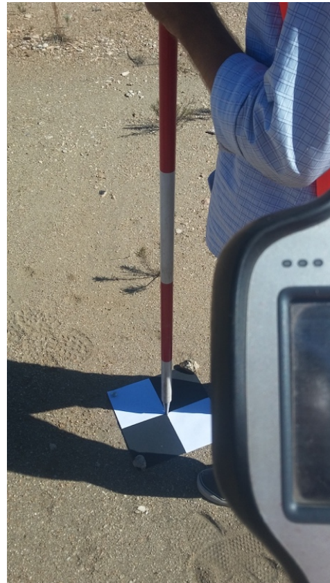
Figura 25 – Señalización y relevamiento de los puntos de control y de apoyo
