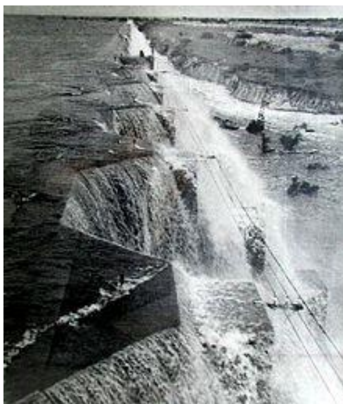
Vista del dique de la margen izquierda de la represa Rincón del Bonete, durante la crecida de abril de 1959
