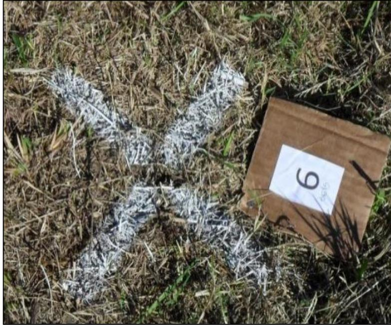
Imagen 12-Señalización de un punto de control en el campo.
