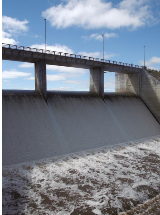
Figura 3-4: Vertedero central de hormigón, represa de PS (MVOTMA, 2017).
