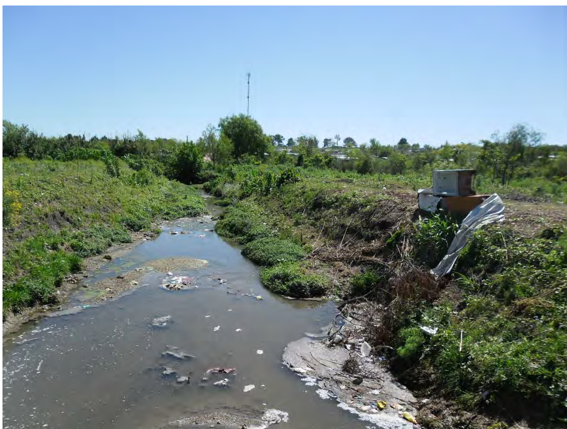
Fig. 15. Punto de descarga del colector pluvial de calle Juncal.
