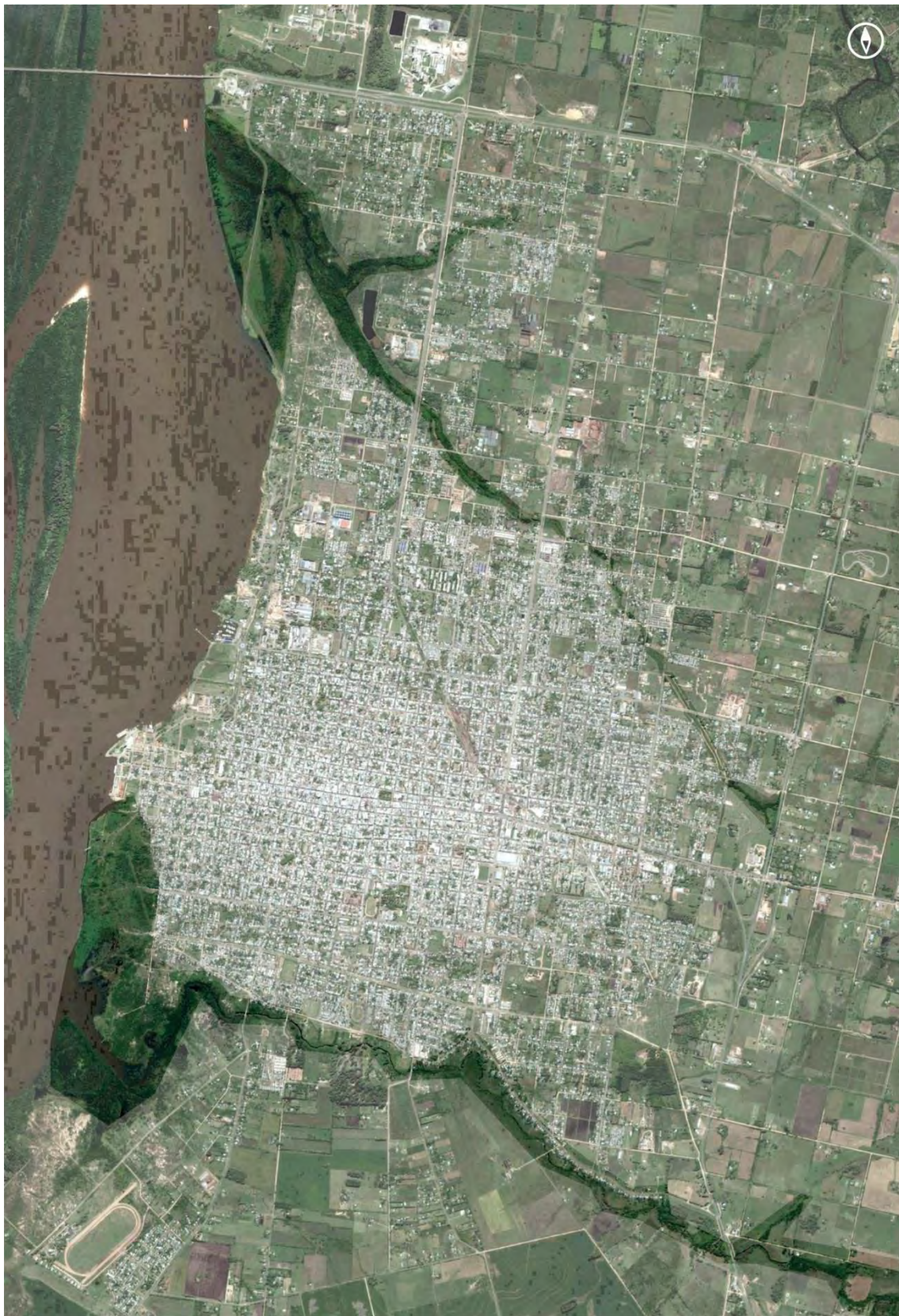
Fig. 3. Arroyo Sacra (Sur) y Arroyo La Curtiembre (Norte).
