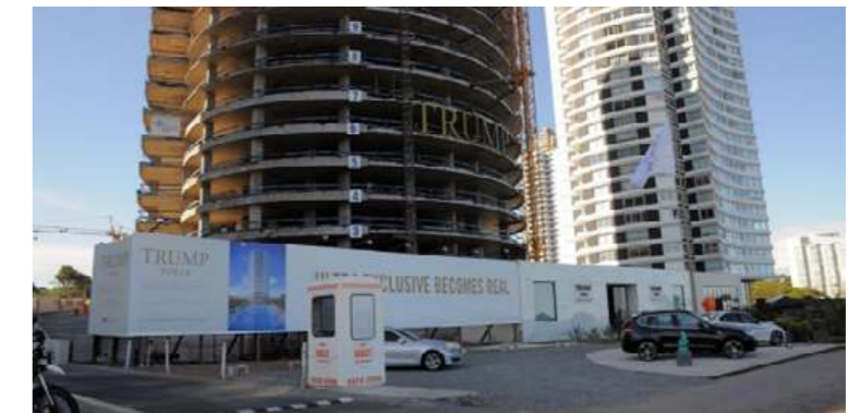
Imagen 84. Trump Tower en construcción, Rbla Battle Pacheco, Punta del Este (2017)
