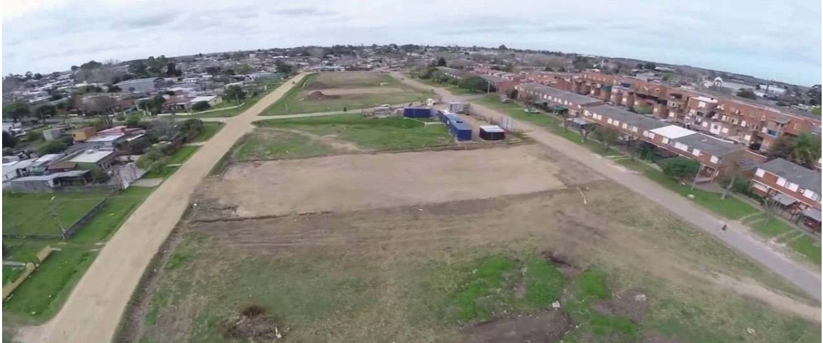
Figura 27 Vista aérea del predio previa a la intervención
