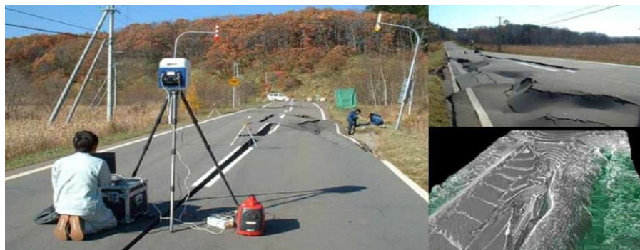
Figura 3.30: TLS aplicado a derrumbes y hundimientos. (Fuente: A. Contreras, 2014)
