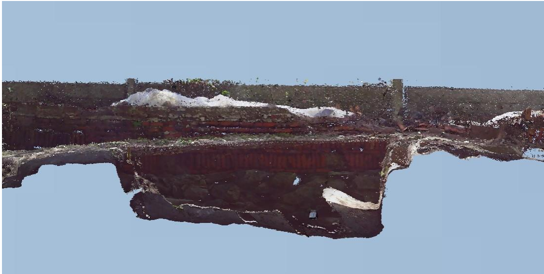
Figura 5.73: Tramo de muro, donde se puede ver la parte que se descubrió. (Fuente: Propia)
