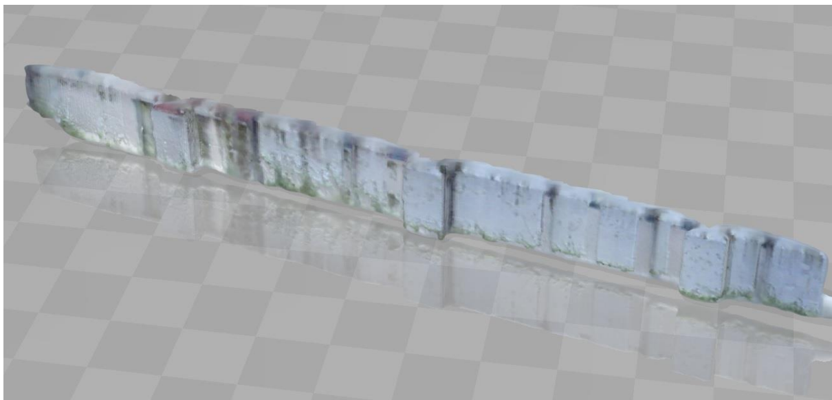
Figura 5.84: Modelo texturizado, usando puntos de parte del muro sobre los contrafuertes. (Fuente: Propia)
