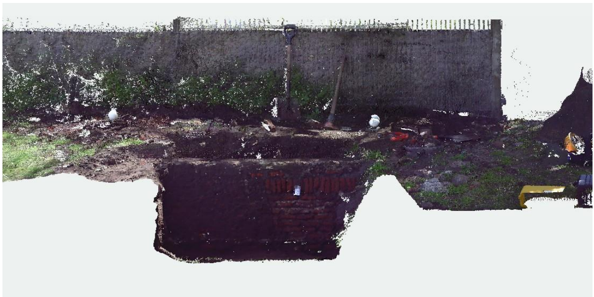
Figura 5.76: Tramo de muro, donde se puede ver la parte que se descubrió. (Fuente: Propia)
