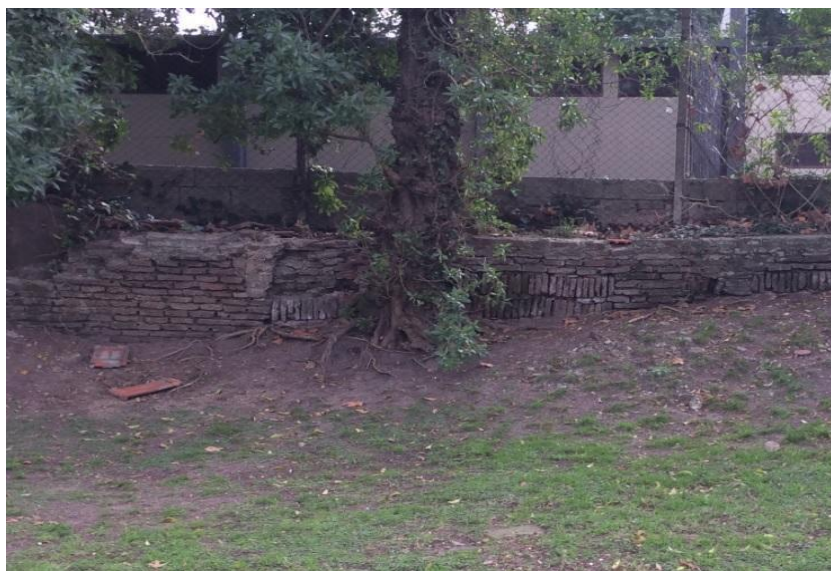
Figura 5.27: Imagen de parte del muro. (Fuente: Propia)
