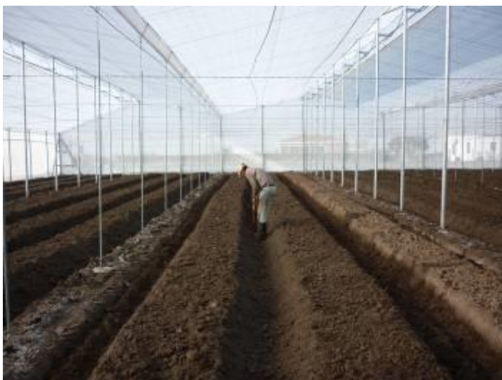
Figura 6. Invernáculos metálicos utilizados en la zona de Salto. Modelo “Multicapilla” o “Raspa y Amagado” originario de Almería, España”. Productor Luis Ferreira. Foto: Matías González Arcos
