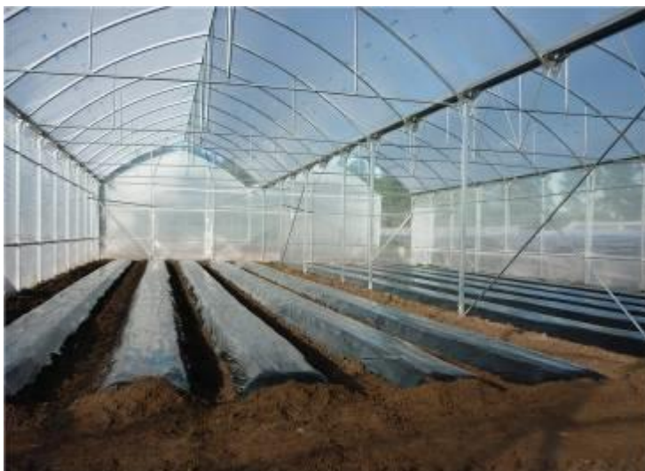
Figura 7. Invernáculos metálicos utilizados en Salto (Estación Experimental INIA Salto Grande). Modelo “Capilla”. Foto: Matías González Arcos
