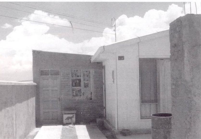
La población debió realizar los cercos perimetrales así como ampliaciones del área básica de la vivienda.(45 m2.)
