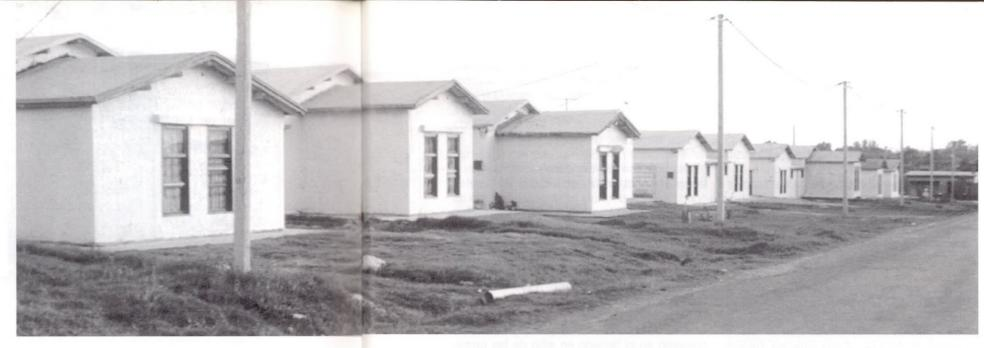
autoconstrucción, se basa en la prefabricación «in situ» de plaquetas de cerámica armada, que una vez ensambladas conforman los cerramientos portantes de la vivienda. La tipología elegida debe adaptarse a la modulación dada por estas plaquetas, debiendo realizarse previamente un despiece de toda la vivienda, calculando la forma y cantidad de elementos que deben fabricarse.
