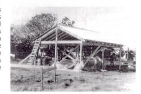
lisa antes de proceder al replanteo y colocación de los conectores metálicos que fijarán la estructura al piso.
