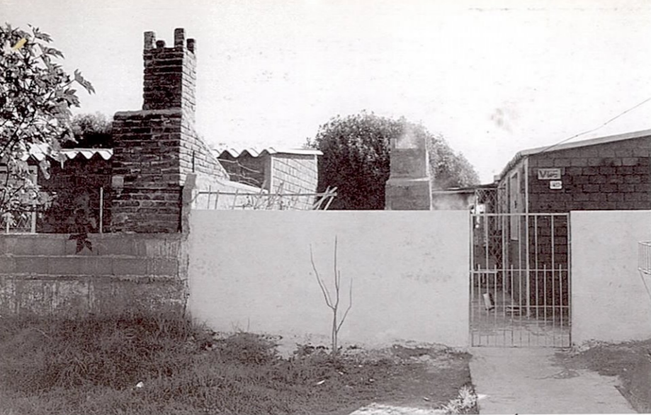
NBE con mejoras : (muros, rejas, parrilleros y revestimiento de ladrillos).
