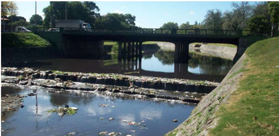
Figura 2.18 - Sección del arroyo en cruce con Millán. Desde aguas arriba hacia aguas abajo, se puede observar el cauce canalizado que se ensancha hacia el puente y por último la presa de nivel. Fuente: Registro fotográfico SEPS.
