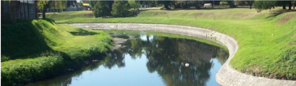
Figura 2.19 - Márgenes del curso en el tramo L. A. de Herrera - Buschental. Se puede observar la diferencia en la fracción visible de las márgenes. Fuente: Relevamiento físico del S.E.P.S.
