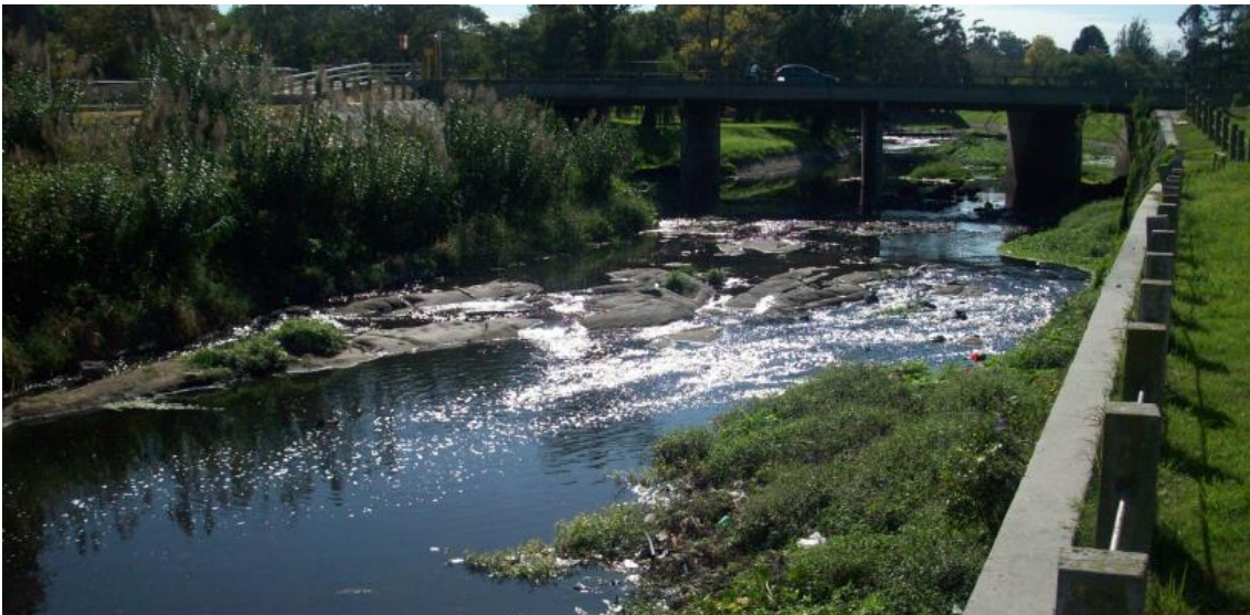
Figura 2.24 - Puente de Agraciada visto desde aguas abajo. Márgenes sin intervención. Fuente: Relevamiento físico S.E.P.S.
