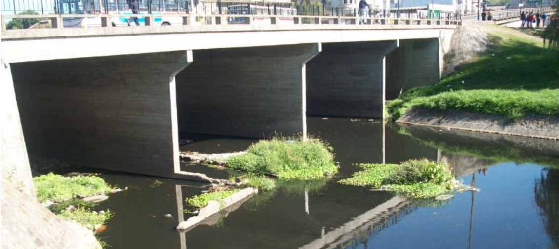
Figura 2.23 - Puente de Agraciada visto desde aguas arriba. Fuente: Relevamiento físico S.E.P.S.
