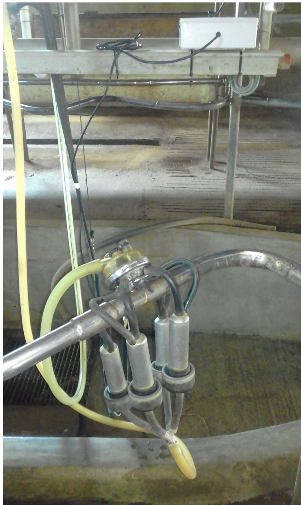
Figura 7.2: Instalación de la caja de la UM
