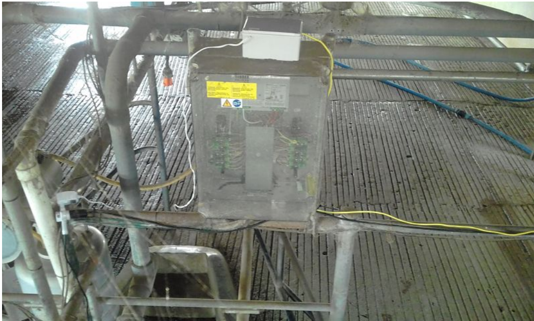
Figura 7.3: Instalación del LecPro, cable Ethernet y cable de alimentación
