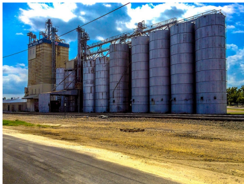
(c) Silo de almacenamiento para minerales
