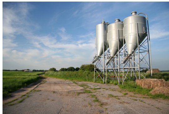
(d) Silo de almacenamiento para granos
