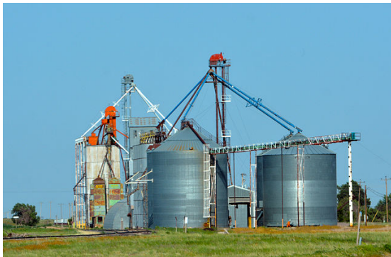
(a) Silo de almacenamiento para granos
