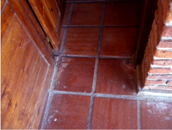
Fotos del leve desnivel entre el pavimento exterior-interior.
