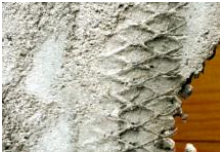
Fotos de la malla de metal desplegado utilizada para la reparación del baño.
