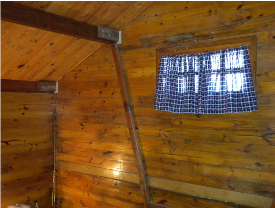
Foto del Tabique desde el Interior de la Vivienda.
