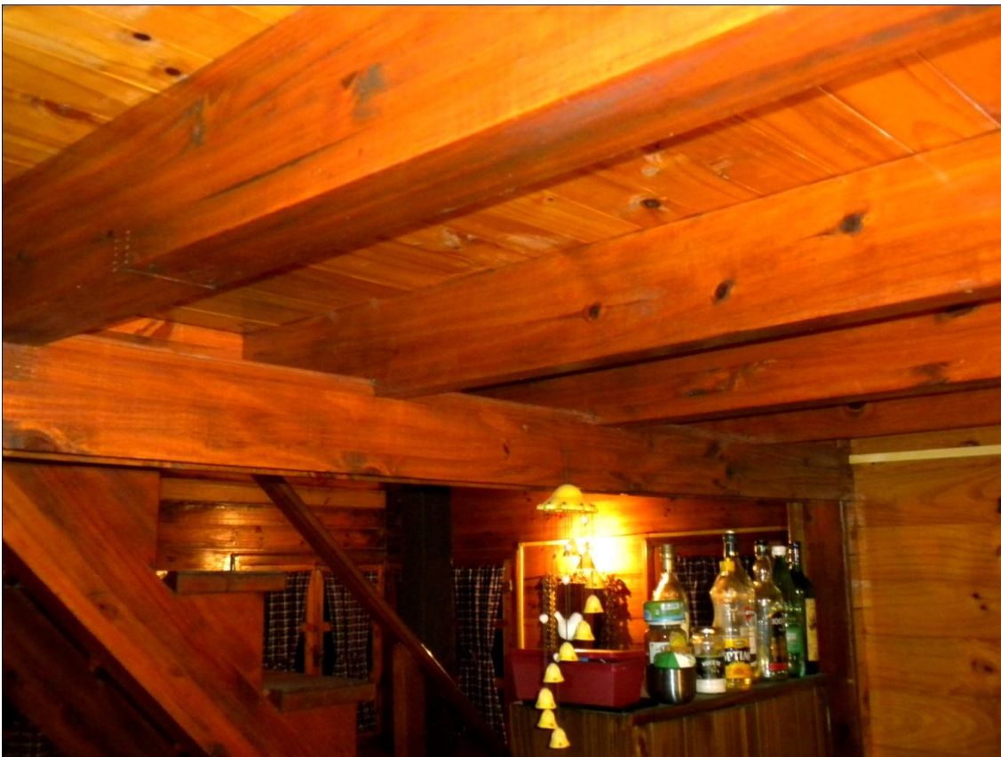
Foto del Entrepiso desde Planta Baja.
