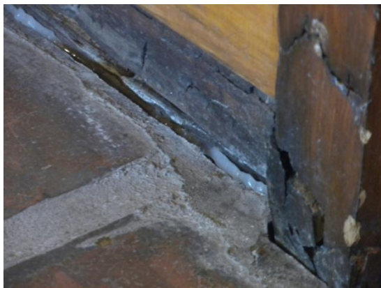
Zonas afectadas del muro y como se encuentran en un grado avanzado de pudrición.
