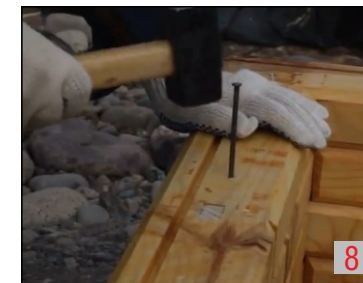
1_platea 2_pernos 3_amure de mampuesto 4_primera hilada colocada 5_colocación de alma 6_segunda hilada 7_colocación de tarugo 8_clavado
