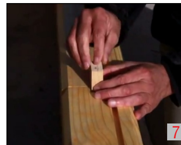
1_platea 2_pernos 3_amure de mampuesto 4_primera hilada colocada 5_colocación de alma 6_segunda hilada 7_colocación de tarugo 8_clavado
