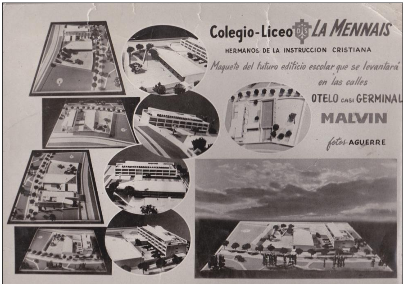
Colegio La Mennais. Mural realizado en ocasión de un aniversario del colegio en el que aparecen varias fotos que corresponden al primer anteproyecto realizado para el colegio, en la misma se ven la rampa y las bóvedas que eran característicos del mismo. Archivo Hermanos mensesianos. Montevideo, Uruguay.
