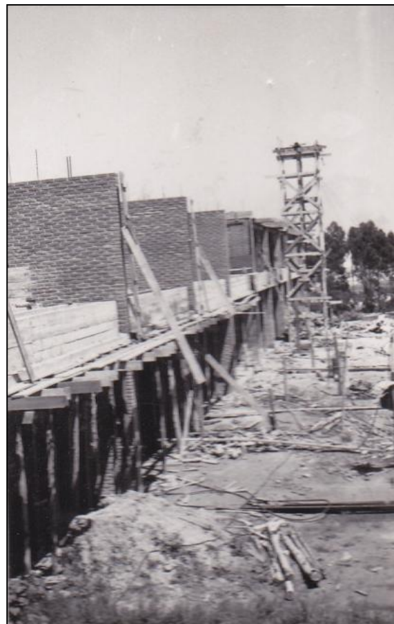
Colegio La Mennais. Obra, enero 1962. Construcción del primer nivel, levantamiento de muros y armadura de vigas. Archivo de los Hermanos Mensesianos. Montevideo, Uruguay.
