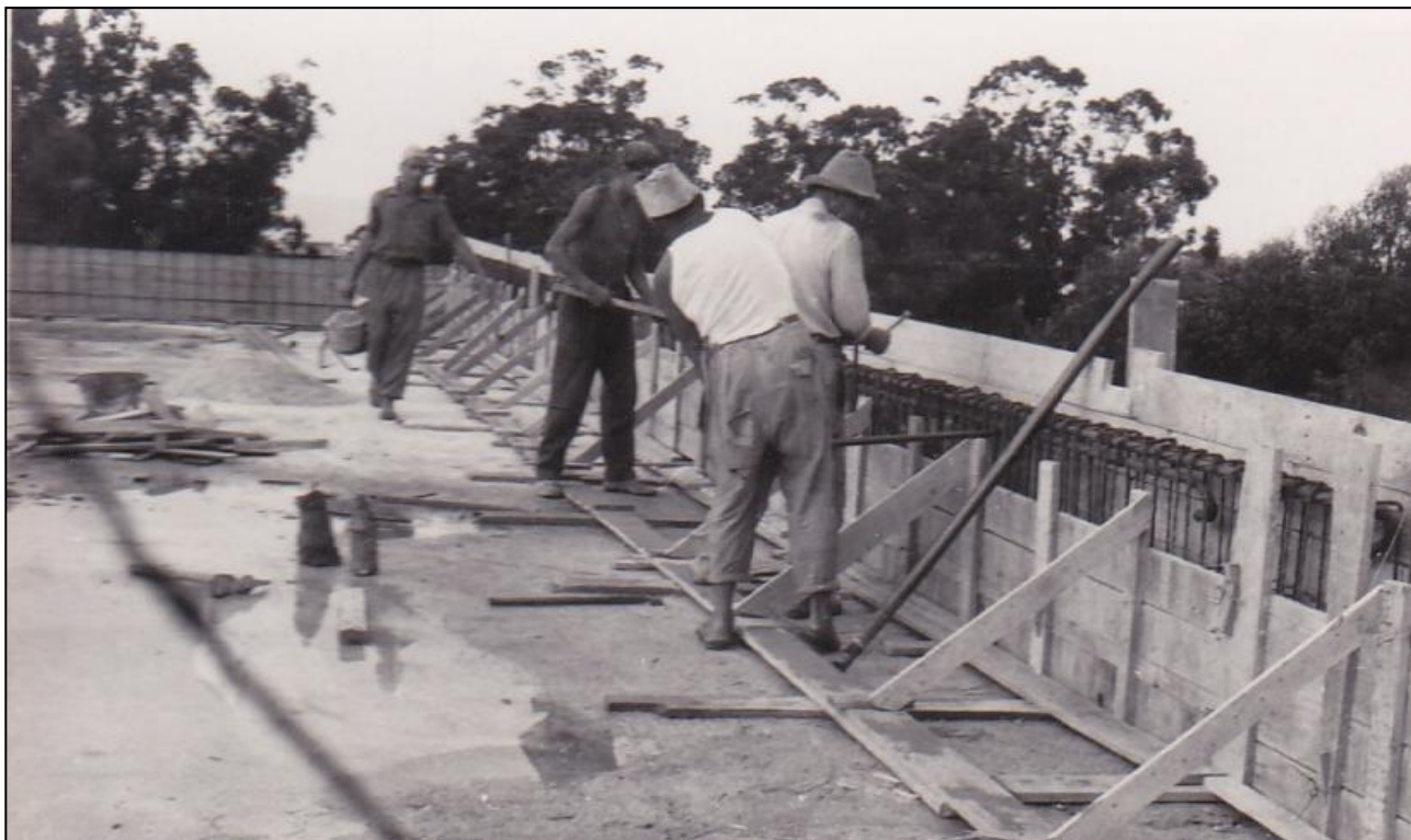
Colegio La Mennais. Obra, 4 de marzo de 1962. Construcción del segundo nivel, encofrado y armadura de vigas invertidas. Archivo de los Hermanos Menesianos. Montevideo, Uruguay.
