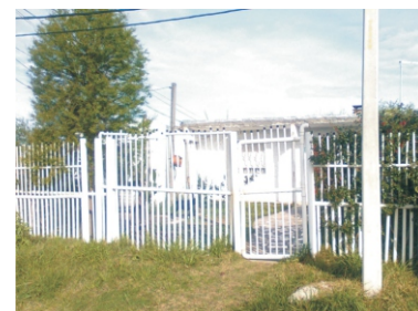
barrio: Paso Hondo referencia: vivienda 08
