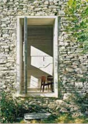
10 Casa en Linescio, Suiza, Buchner Bründler arquitectos, 2011. Los robustos muros de piedra exteriores forma parte de una construcción existente de más de 200 años de antigüedad, se utilizaron como "encofrado exterior" para la creación de un nuevo interior de hormigón armado; el cual fue llenado delicadamente. La nueva cáscara de hormigón enaltece el carácter de lo existente funcionando como un marco.
