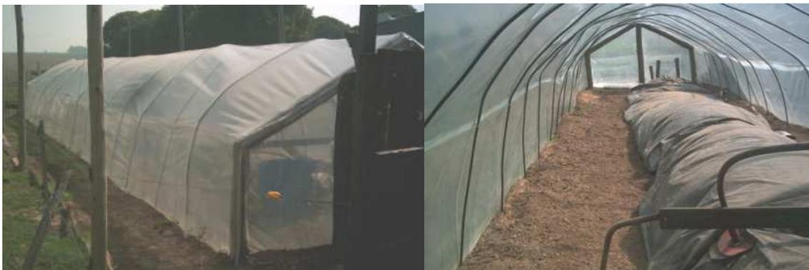
**Ilustración 2- Invernadero construido con postes de madera, varillas de hierro de 8mm de diámetro y nylon transparente de invernadero.**
