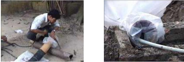
Ilustración 21 – La doble bolsa se hace pasar por los tubos de salida y entrada de PVC.
