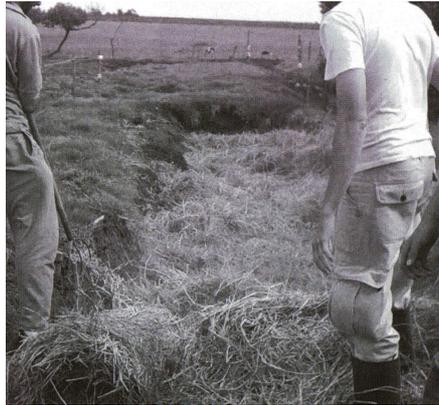
Ilustración 12 – Colocación de paja en la zanja. <sup>7</sup>
