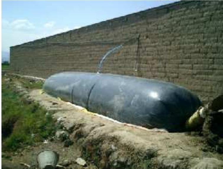
Ilustración 11 – Biodigestor de polietileno, tipo taiwanés.
