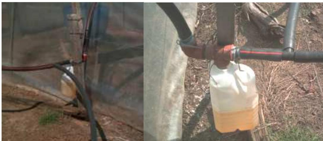
**Ilustración 4- Detalle de la válvula seguridad.**
