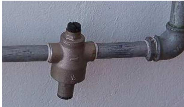
**Ilustración 32 - Válvulas reductoras de presión**
