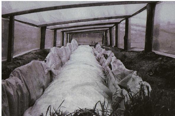
Ilustración 13 – Biodigestor con invernadero. También tiene la zanja apuntalada y bolsas de plastillera como aislante y protección adicional. <sup>8</sup>
