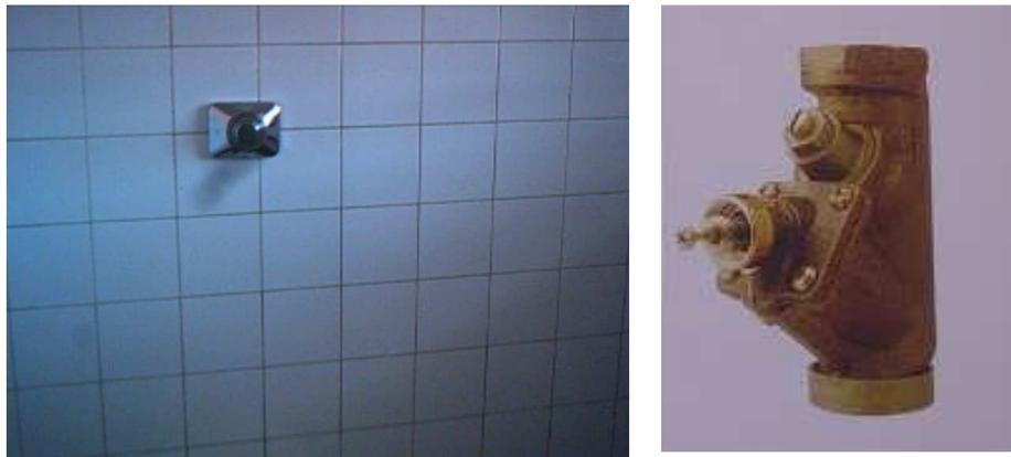
Ilustración 27 - Válvula de descarga
