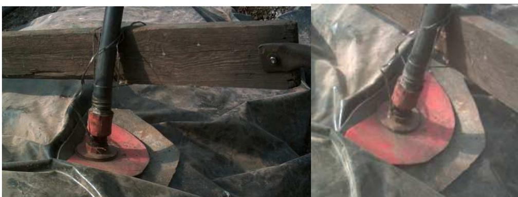
**Ilustración 3- Detalle de la válvula de salida del biogás desde la bolsa de polietileno.**
