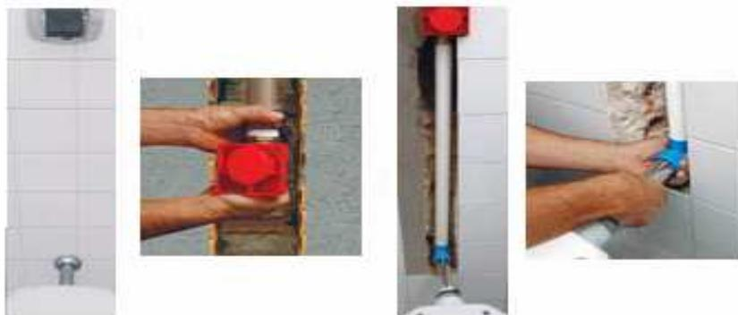
Ilustración 30 - Colocación de cisterna
