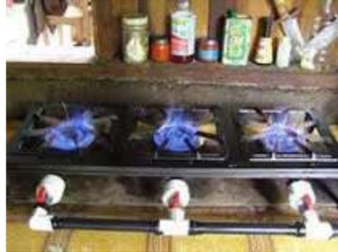
Ilustración 27 – Aplicación de biogás para cocción de alimentos.
