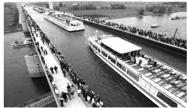
Figura 15. Puente Acuífero. Elbe. Elbe Water Bridge.
