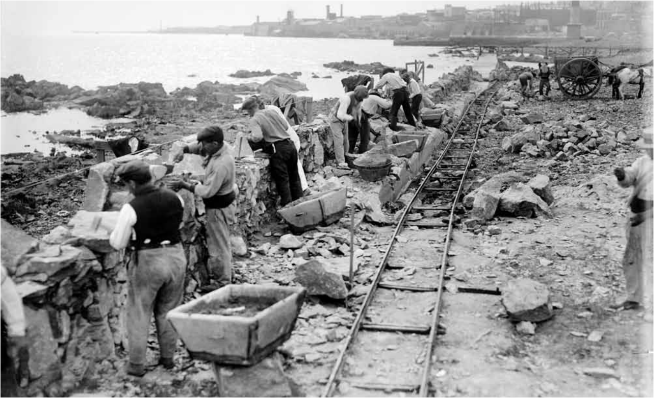
Construcción del muro de contención de la Rambla Sur. 1923-1935 (aprox.). Construction of retaining wall along the southern section of the Rambla Promenade. Around 1923 - 1935. Foto: 18607FMHGE.CMDF.IMM.UY - Autor: S.d./IM
