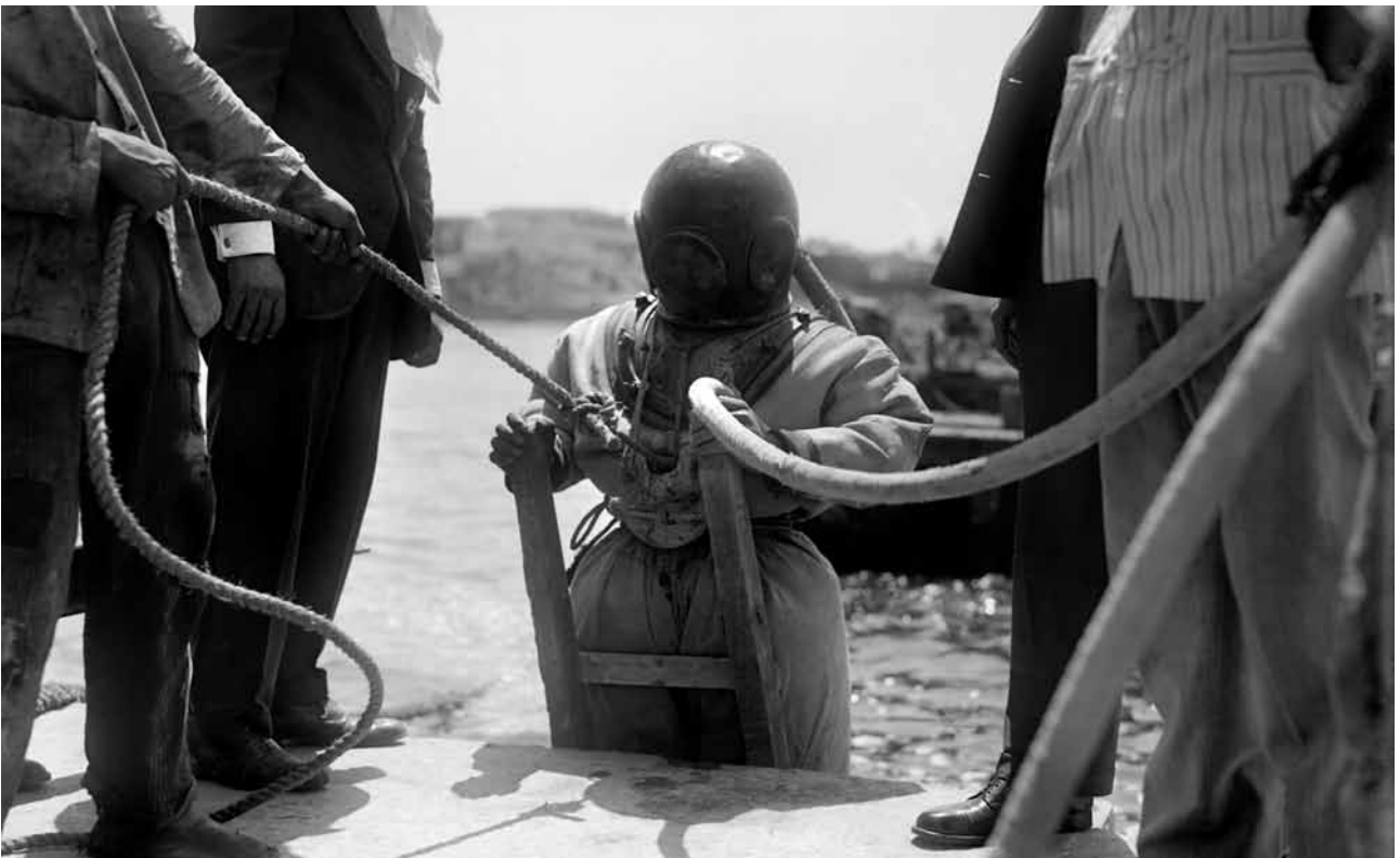
Probablemente trabajos de buceo para el control de las obras de construcción de la Rambla Sur por debajo del nivel del mar. 1923-1935 (aprox.). Probably, diving operations for controlling the construction of the southern section of the Rambla Promenade below sea level. Around 1923 - 1935. Foto: 18722FMHGE.CMDF.IMM.UY - Autor: S.d./IM
