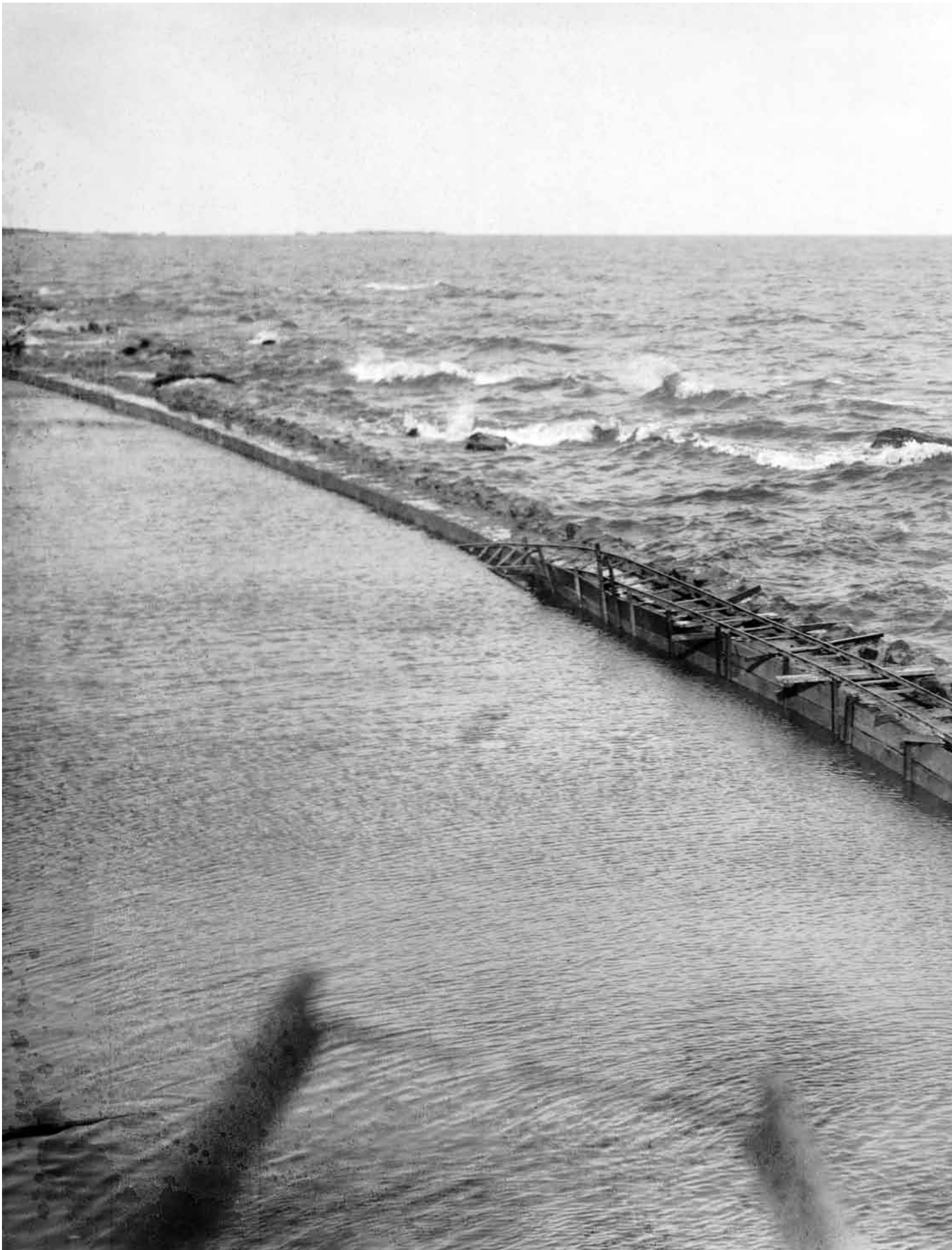
Construcción del muro de contención de la Rambla Sur. 1923 - 1935 (aprox.). Construction of retaining wall along the southern section of the Rambla Promenade. Around 1923 - 1935. Foto: 18619FMHGE.CMDF.IMM.UY - Autor: S.d./IM
