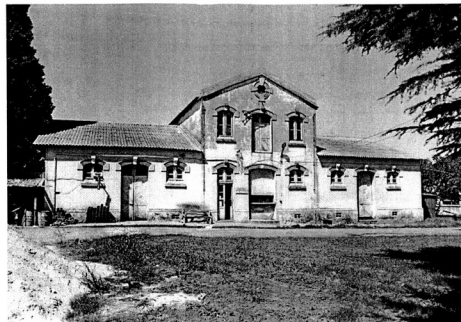
Fig. 25 - Construcciones del conjunto edilicio de la Granja Modelo.
