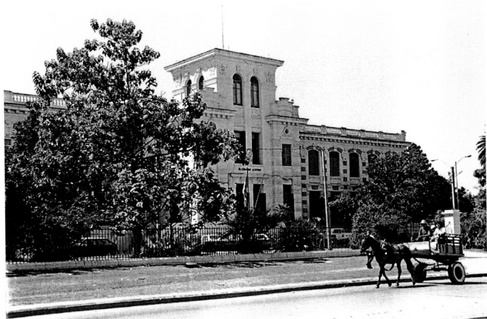
Fig. 38 - La desaparición de la torre de observaciones meteorológicas modificó las proporciones originales.
