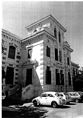
Fig. 31 - Escalera lateral de acceso, vista actual.
