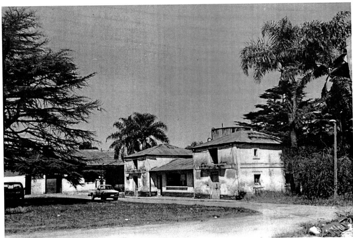
Fig. 26 - Construcciones del conjunto edilicio de la Granja Modelo.
