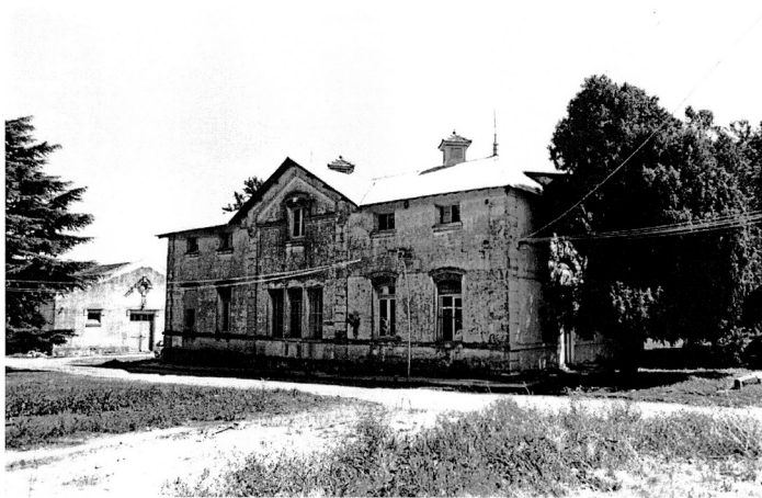
Fig. 27 - Construcciones del conjunto edilicio de la Granja Modelo.
