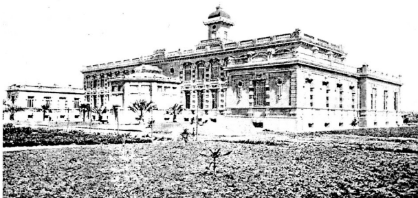
Fig. 30 - Fachada posterior. La proyección del anfiteatro y las alas laterales, generaron un espacio de intermediación con el campo experimental.
