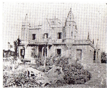
Fig. 200 — Casa-quinta de Francisco Gómez — (Calle Fco. Gómez esq. Avda. Agraciada N° 3665) — Vista exterior.
