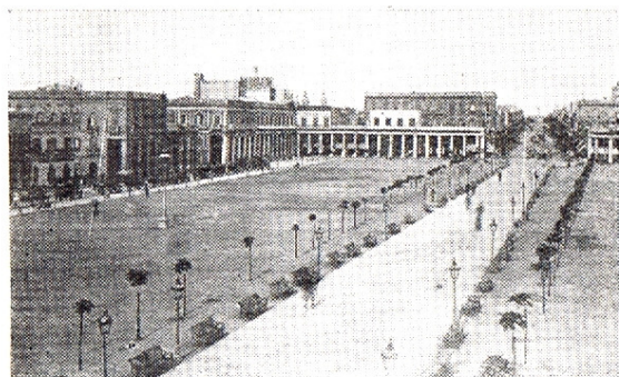
Fig. 80 — Sistemización de la Plaza Independencia — Vista exterior.
