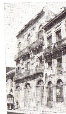
Fig. 205 — Casa de la calle La Marseillaise entre Zabala y Misiones — Vista exterior.
