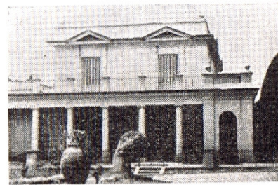
Fig. 101 — Casa-quinta de Jackson (Larrañaga Nº 4184) — Vista exterior.
