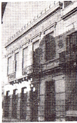
Fig. 196 — Casa de Carlos Shaw — (Calle Colón N° 1410) — Vista exterior.
