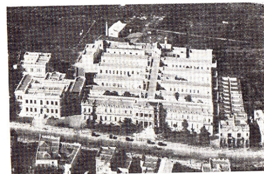
Fig. 170 — Hospital Militar — Vista aérea.
