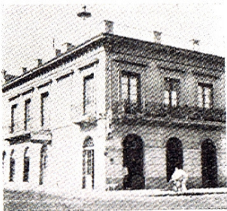
Fig. 98 — Casa de la calle Ciudadela esq. Piedras 744 - 50 — Vista exterior.
