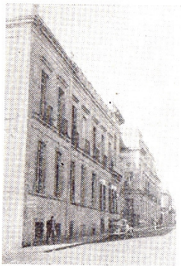
Fig. 171 — Hospital de Caridad — Vista exterior sobre la calle Washington.
