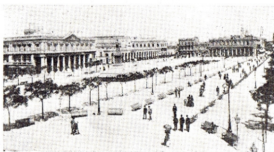
Fig. 81 — Sistemización de la Plaza Independencia — Vista exterior.
