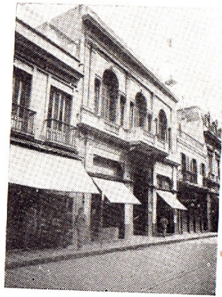
Fig. 177 — Casa de Agustín de Castro — (Calle 25 de Mayo entre Treinta y Tres e Itzaingó) — Vista exterior.
