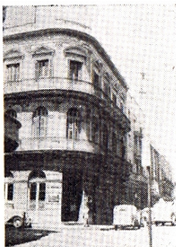
Fig. 93 — Casa de la calle Piedras N° 442 esq. Misiones — Vista exterior.
