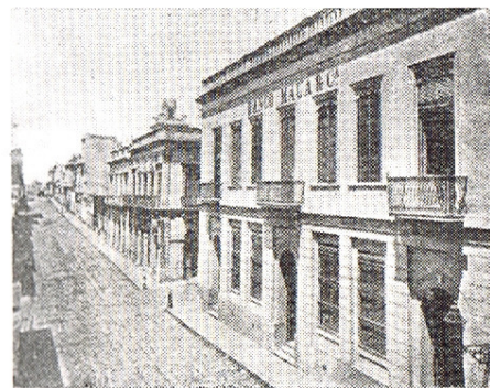
Fig. 68 — Banco Mauá — Vista exterior.
