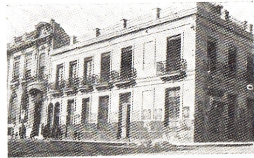
Fig. 25 — Casa de la calle Paysandú esq. Florida — Vista exterior.
