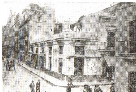
Fig. 19 — Casa de la calle 25 de Mayo esq. Bartolomé Mitre — Vista exterior.
