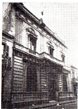
Fig. 158 — Administración de la Loteria Nacional — Vista exterior.
