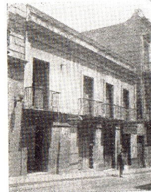
Fig. 27 — Casa de la calle Treinta y Tres entre 25 de Mayo y Cerrito — Vista exterior.
