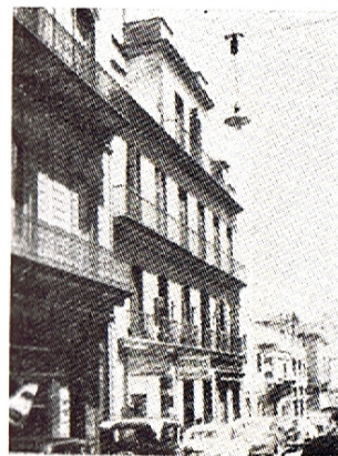
Fig. 34 — Casa de la calle Bmé. Mitre Nos. 1427-1437 — Vista exterior.
