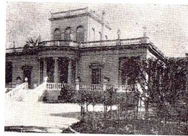
Fig. 179 — Casa-quinta de Morales — Vista exterior.
