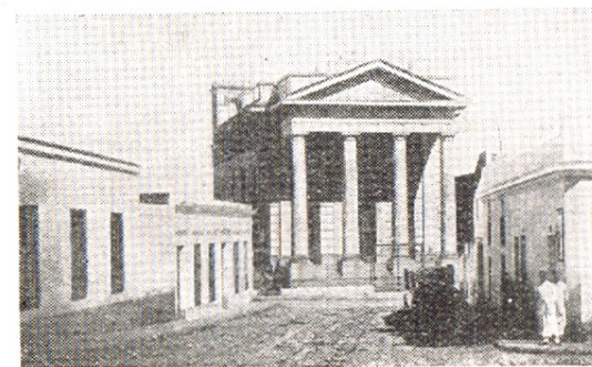
Fig. 2 — Templo Inglés — Vista exterior (antes de las reformas)
