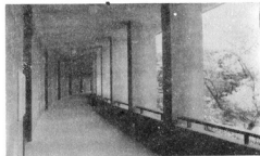
Fig. 33. Facultad de Arquitectura Galería planta alta
