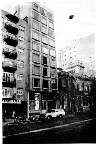
Fig. 74. Edificio de la Comisión Honoraria para la Lucha Antituberculosa Fachada principal
