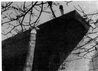
Fig. 7. Facultad de Arquitectura Covisa. Detalle
