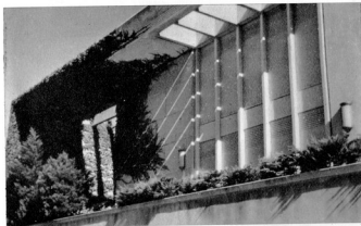
Fig. 93. Vivienda Barreira El estrecho espacio que la separa de la calle Guaná
