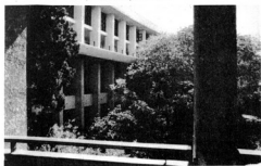
Fig. 25. Facultad de Arquitectura Ampliación del Ala Sur
