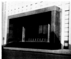
Fig. 41. Palacio de la Luz Acceso principal
