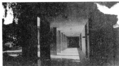
Fig. 32. Facultad de Arquitectura Galería planta baja
