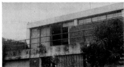
Fig. 110. Vivienda Florines Fachada principal
