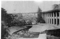
Fig. 35. Facultad de Arquitectura Fachada interior
