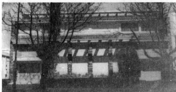
Fig. 103. Vivienda Dr. Dighiero Fachada
