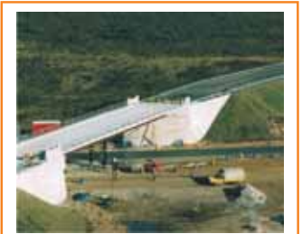
Intercambiador rutas 9 y 93 Fuente: www.saceem.com.uy
